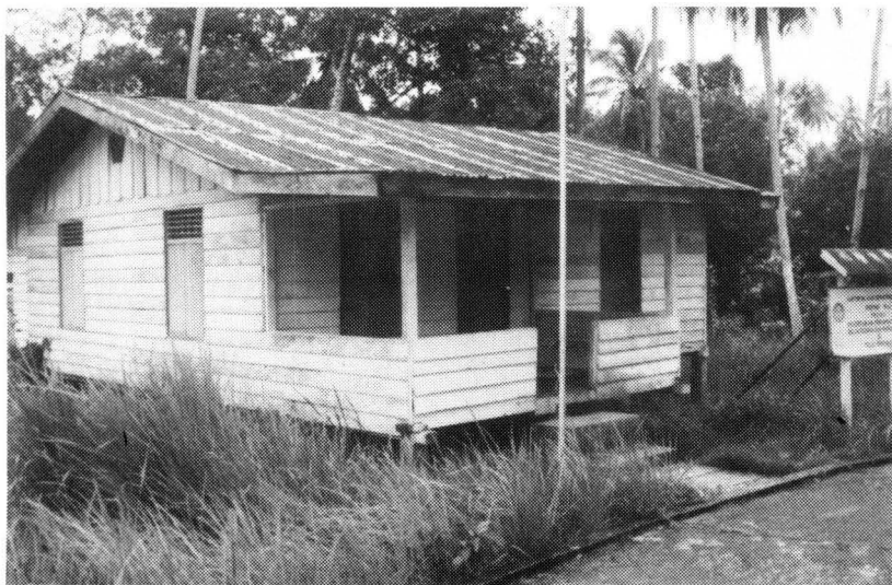
Foto 52. Bangunan Kantor Proyek Peetarian Peninggalan Sejarah yang sudah tidak dipergunakan lagi dibiarkan begitu saja.
