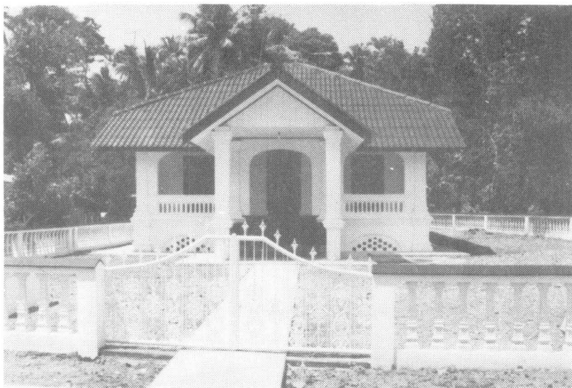
Foto 36. Bangunan baru yang menurut ceritanya adalah bangunan lama yang dipunggar tanpa sepengetahuan Dit. Perlindungan Pembinaan Sejarah dan Purbakala.
