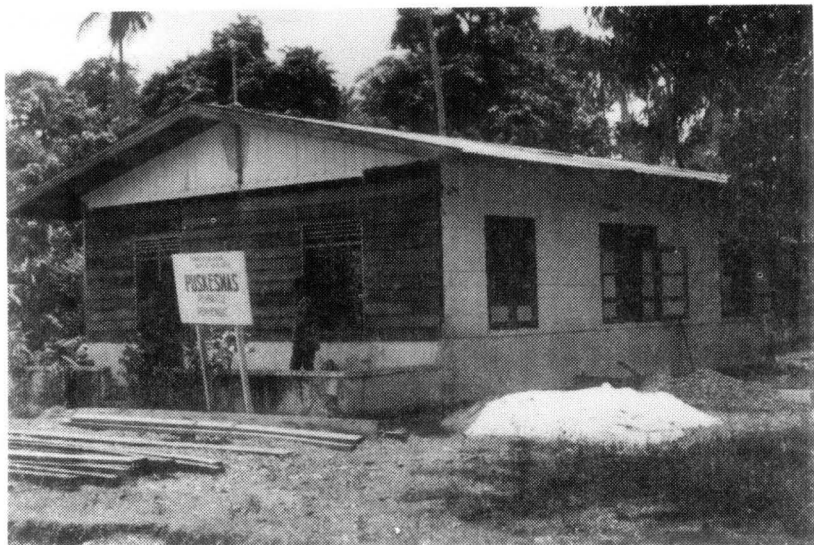
Foto 65. Puskesmas Pembantu desa Penyengat yang sedang direnovasi.
