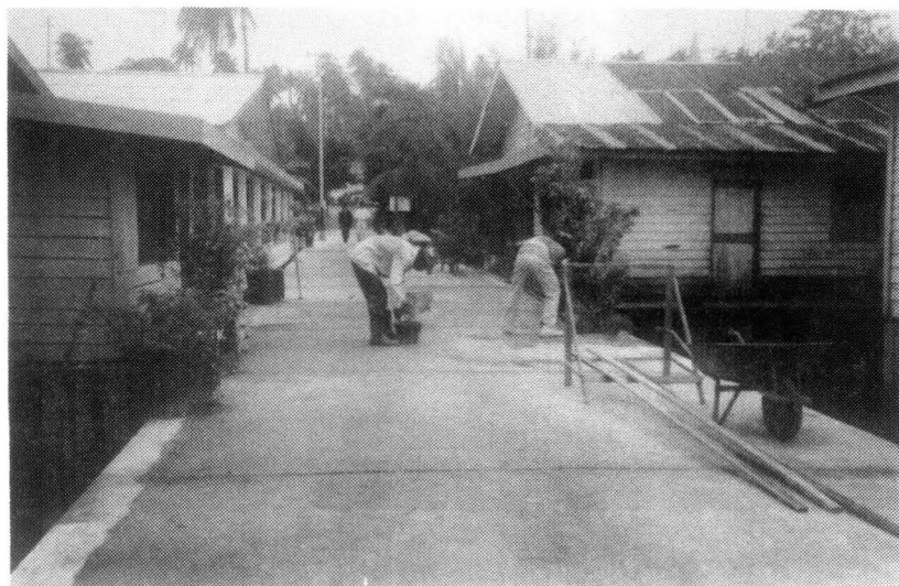
Foto 78. Perbaikan jalan utama menuju pintu kawasan wisata Penyengat.
