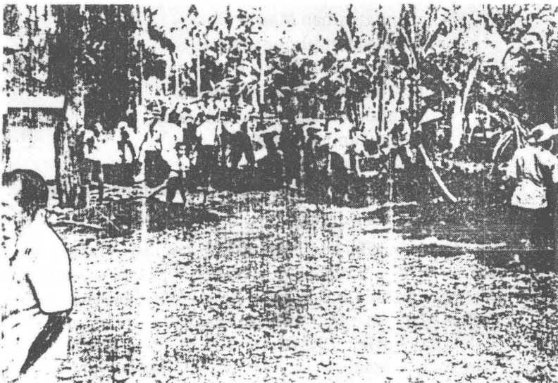
Gotong royong yang digerakkan LKMD dalam perbaikan jalan Desa Benua
