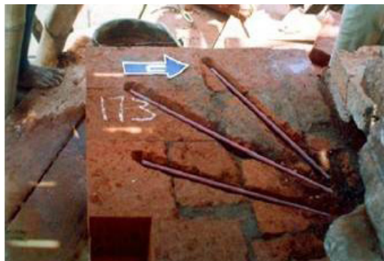
Foto 26. Perbaikan bagian atap menggunakan angkur besi
