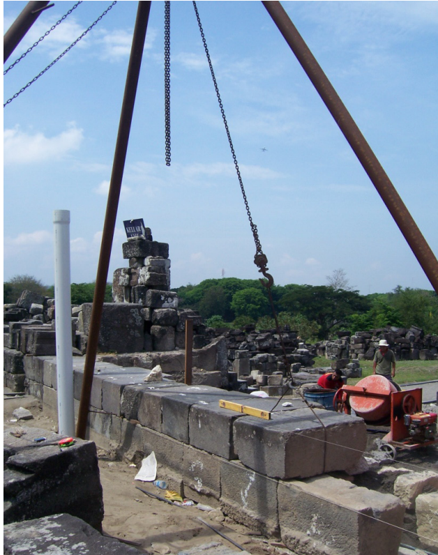
Gambar 2.9. Pengangkatan batu menggunakan katrol dan tower crane
