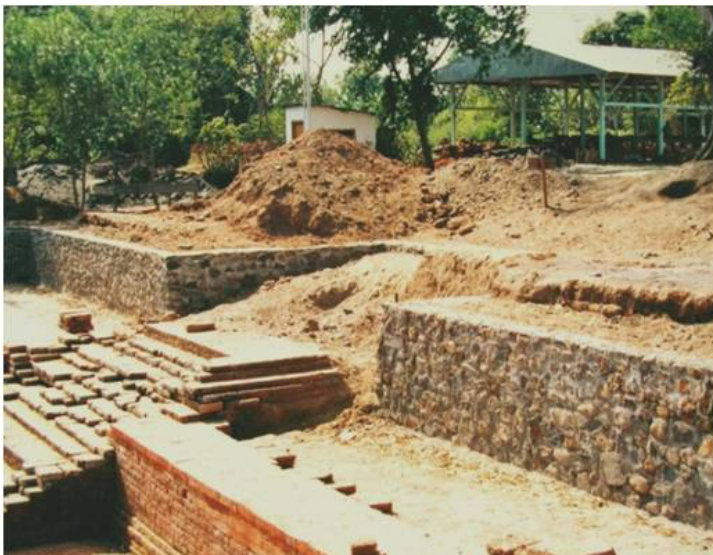
Foto 23. Perkuatan dinding teras menggunakan turap pasangan batu kali
