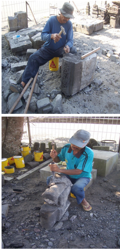
Gambar 2.11. Perbaikan batu yang dibongkar
