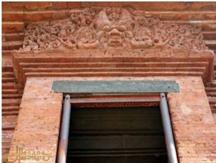
Foto 28. Perkuatan bagian atap menggunakan tiang penyangga besi
