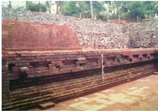
Foto 24. Pemasangan kembali dinding teras
