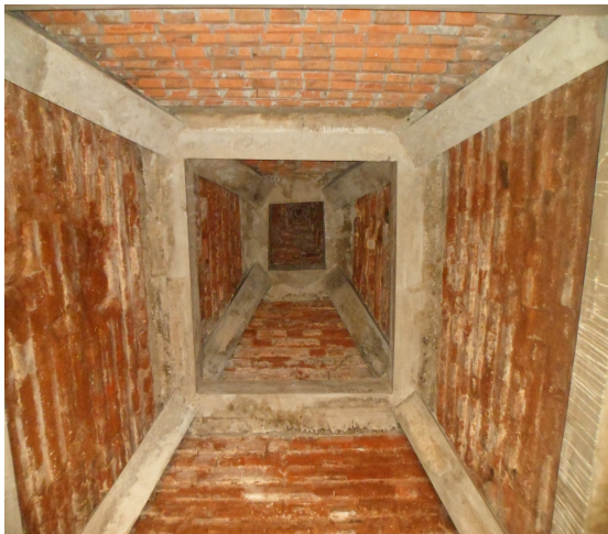
Foto 32. Perkuatan struktur di bagian atap candi menggunakan kerangka beton
