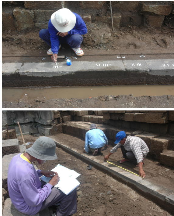
Gambar 2.7. Penggambaran dan penandaan batu yang dibongkar per lapis
