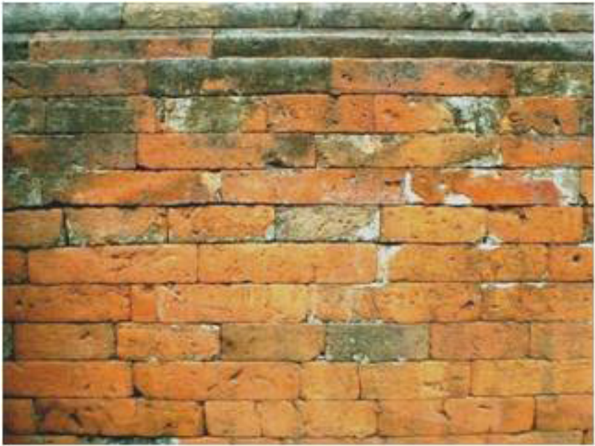
Foto 2. Pola susun bata Candi Tikus Trowulan Jawa Timur
