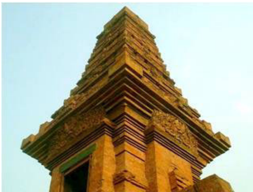
Foto 27. Bagian atap setelah diperbaiki
