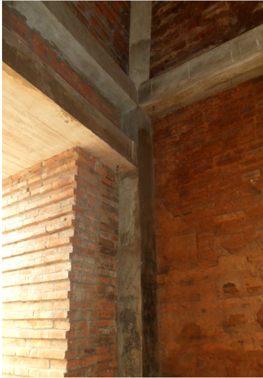
Foto 31. Perkuatan struktur di bagian dalam bilik candi menggunakan kerangka beton
