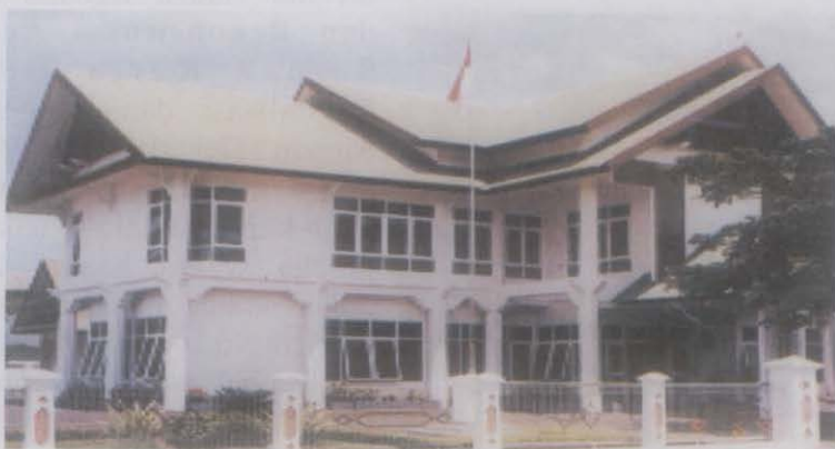
Foto gedung BPSNT Banda Aceh sebelum musibah gempa dan Tsunami 26 Desember 2004
