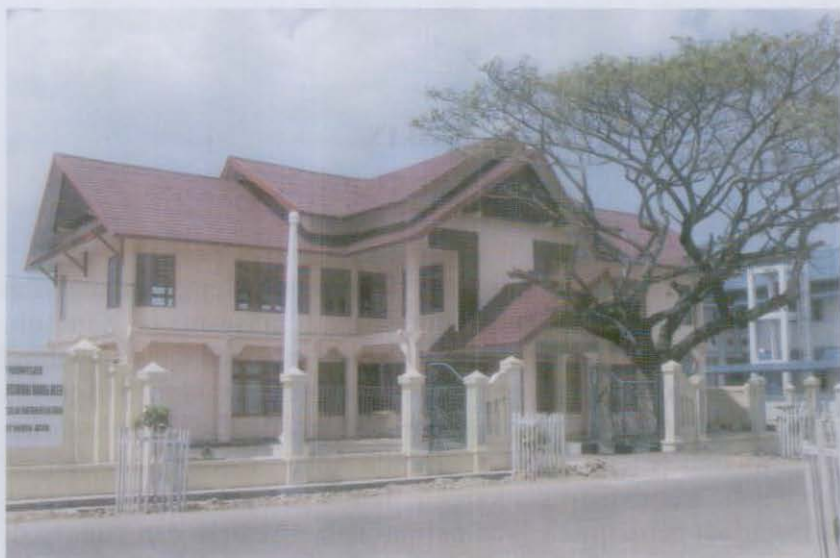
Foto Gedung BPSNT Banda Aceh yang dibangun kembali oleh BRR Aceh-Nias tahun 2006 ditempati kembali tanggal 22 Februari 2007
