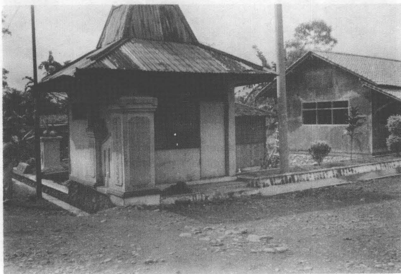
Gb 12. Bangunan gapura di jalan masuk balai Desa Cikidang.
