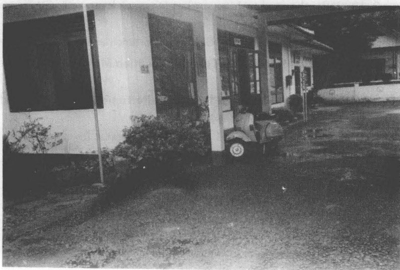
Gb 1. Gedung kantor kecamatan Cilongok Kabupaten Dati II Banyumas.
