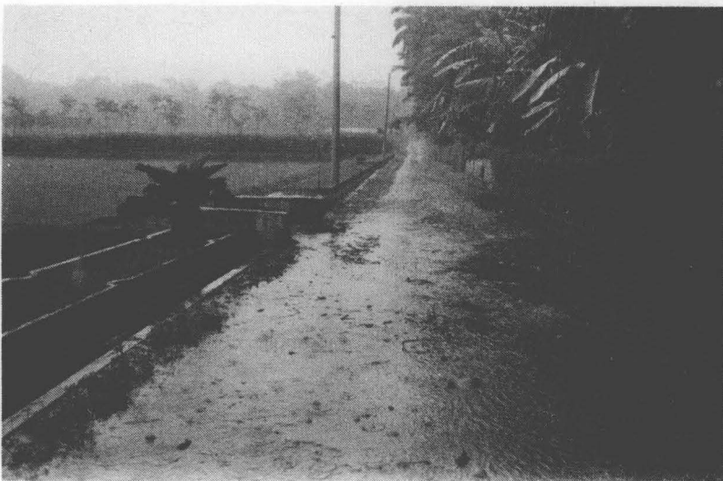
Gb 24. Pembangunan jalan desa atas prakarsa Kelompencapir.
