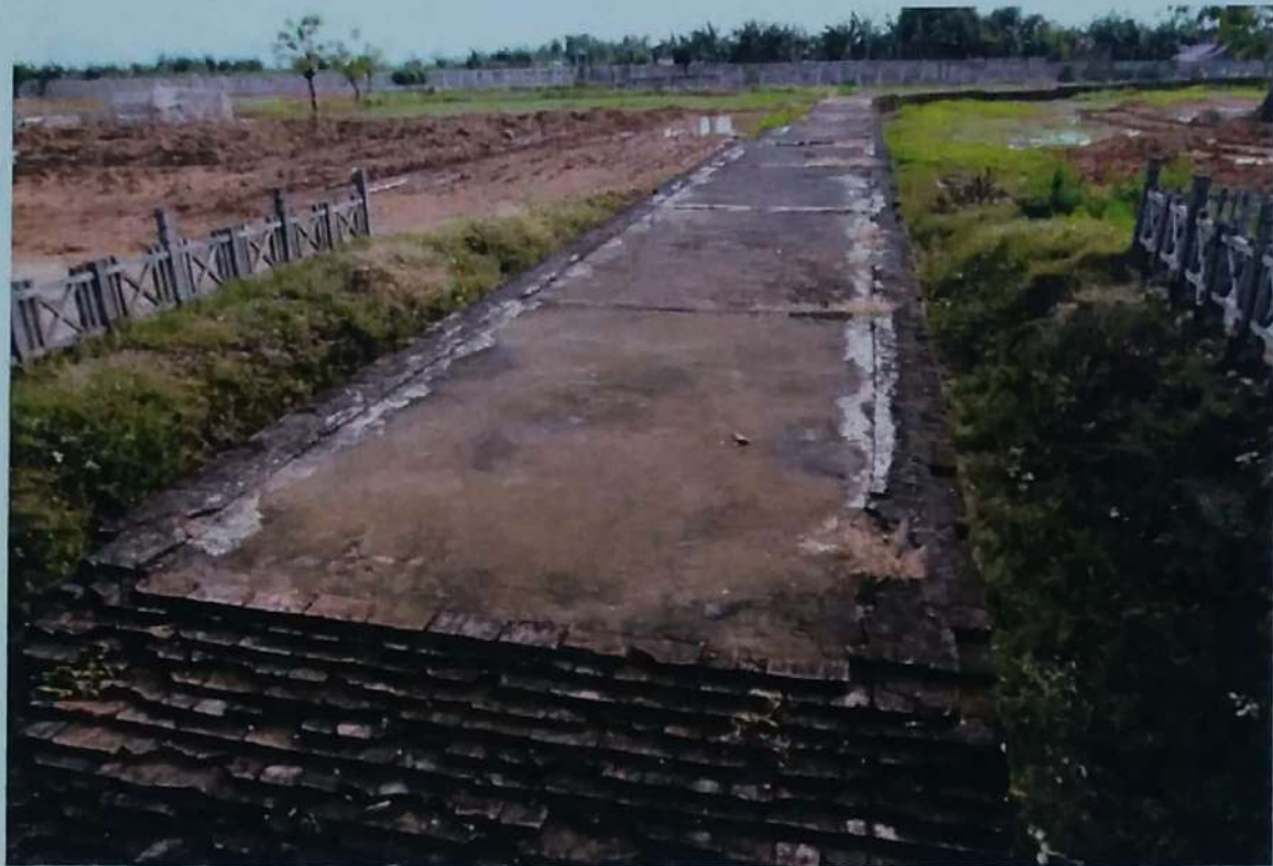
Struktur dinding benteng Somba Opu bagian timur
