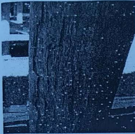
Kondisi tiang lumbung terjadi pengelupasan Lantai yang mengalami kerapuan
