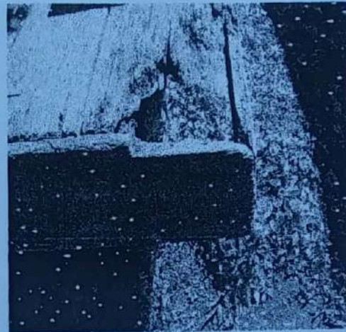
Kondisi tiang lumbung terjadi pengelupasan Lantai yang mengalami kerapuan
