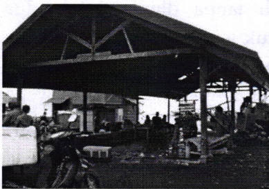
Bangunan TPI lama
