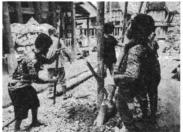
Foto. 5 Menancapkan bambu untuk menopang Bangunan yang akan dibongkar
