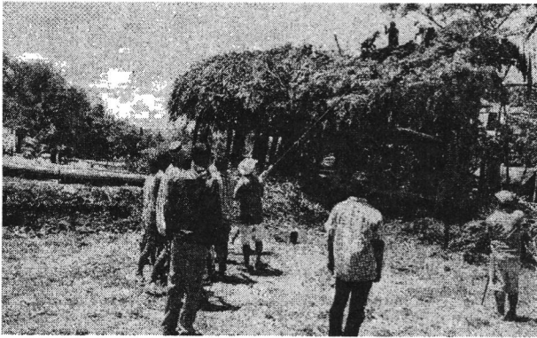
Foto 10. Proses Pembongkaran bangunan lama
