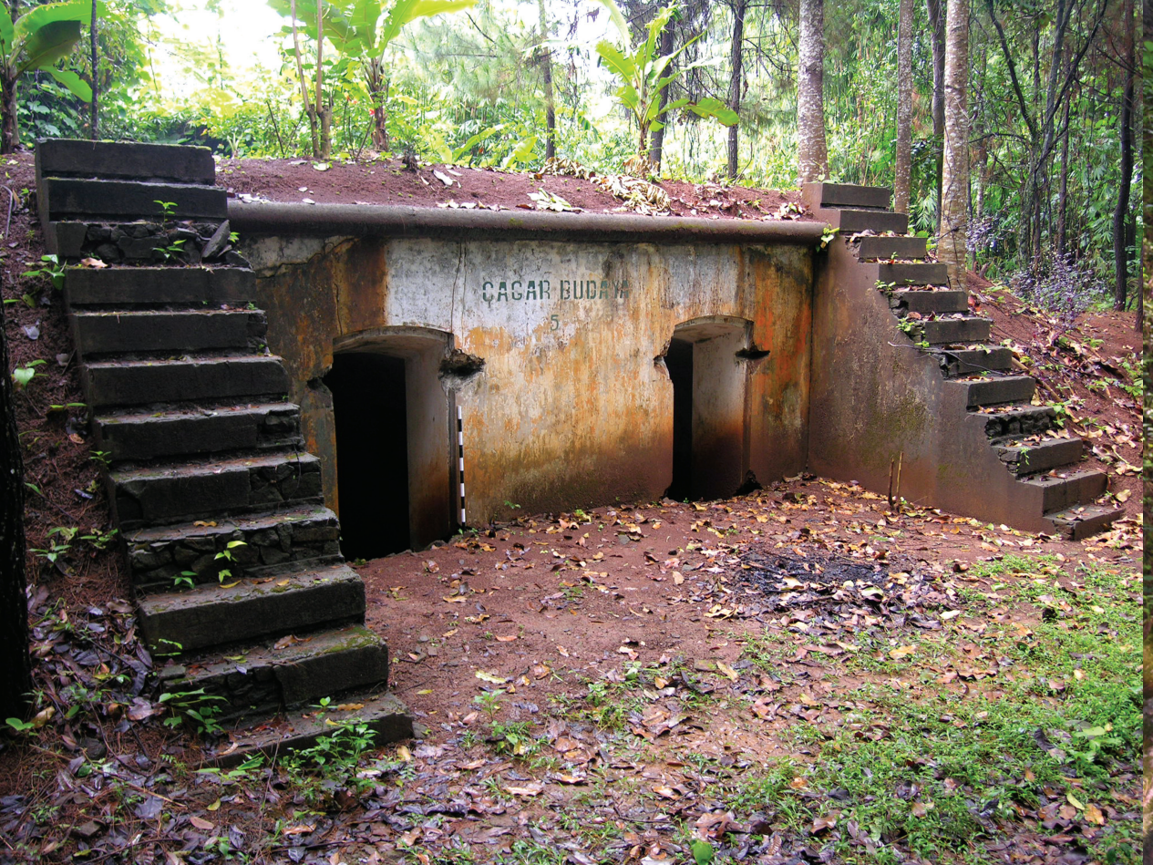
Bunker Gunung dan Gunung Kunci di Kabupaten Sumedang adalah bagian dari rangkaian benteng pertahanan kota Bandung pada masa kolonial Belanda
