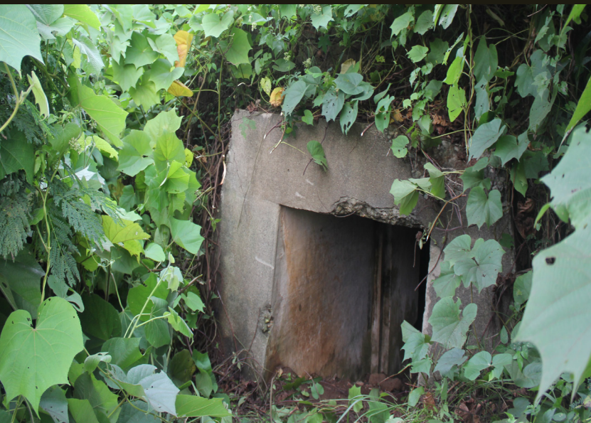
Bunker-bunker dan benteng di Kabupaten Bandung: Bunker Blok Tunjung, Benteng Tangkil, dan Bunker Bukit 500
