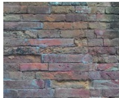
Foto 3. Pengelupasan pada Permukaan Bata
