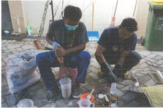
Proses pengolesan adonan resin, talk, dan catalys (Dok. BPCB Kalimantan Timur)
