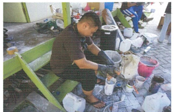
Proses pencampuran resin, pigmen warna, dan catalys (Dok. BPCB Kalimantan Timur)
