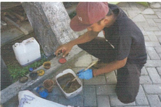
Proses pencampuran resin dengan pigmen warna (Dok. BPCB Kalimantan Timur)
