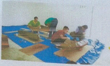
Foto 1. Membuat batas pemisah yupa antara sisa depan dan belakang dengan menggunakan gypsum.
