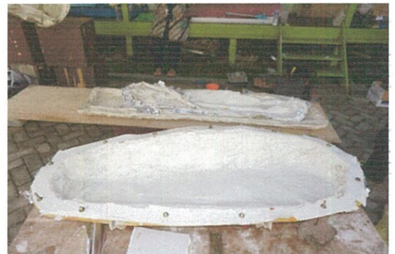
Proses pengolesan silicon oil (Dok. BPCB Kalimantan Timur)
