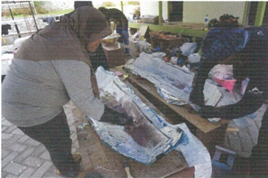
Proses memberikan mat/serat fiber pada cetakan negatif yang telah terlapisi adonan (Dok. BPCB Kalimantan Timur)
