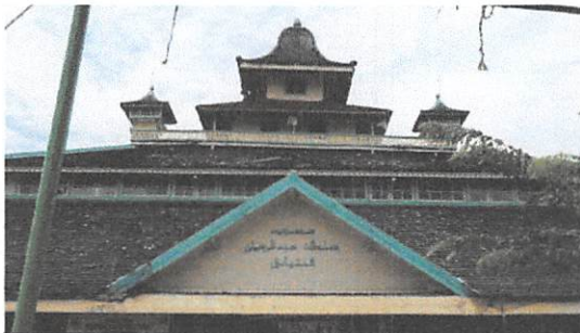
Foto 11. Atap masjid Dok. BPCB Kaltim, 2019)
