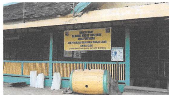
Foto 16. Spanduk pemberitahuan restorasi masjid (Dok. BPCB Kaltim, 2019)
