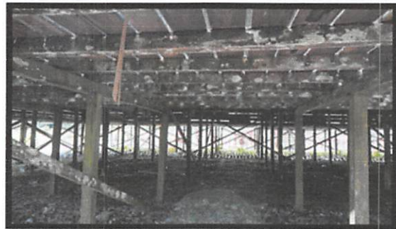
Salah satu Cagar Budaya (Rumah Betang, Desa Lingga, Kab. Kubu Raya) dalam kondisi terawat namun mengalami pelapukan, berlumut, lichen pada bagian gelagar lantai
