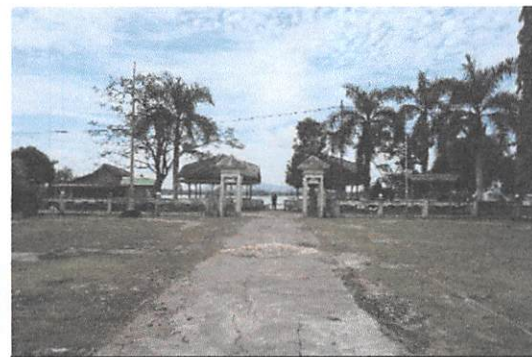
Foto 43. Lingkungan keraton tampak depan (Dok. BPCB Kaltim, 2019)
