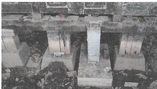
Foto 15. Perkuatan terhadap tiang-tiang penyokong lantai masjid (Dok. BPCB Kaltim, 2019)
