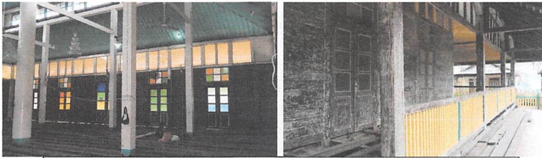
Foto 13. Dinding masjid yang dilakukan pengupasan catnya (Dok. BPCB Kaltim, 2019)
