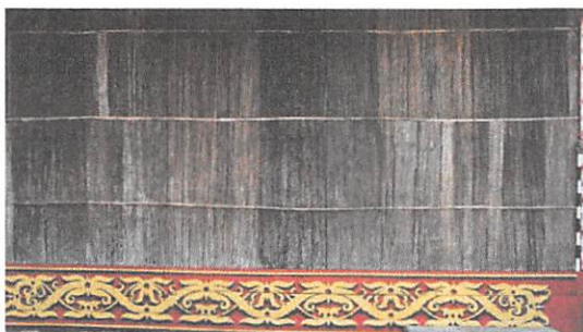
Foto 34. Dinding luar rumah terbuat dari kulit kayu meranti merah (Dok. BPCB Kaltim, 2019)
