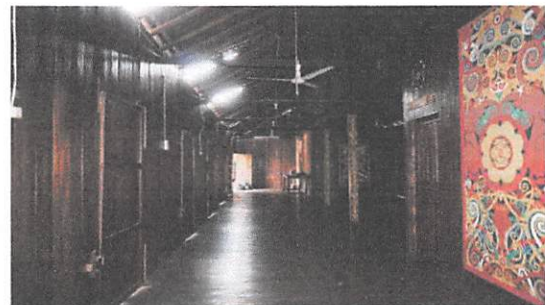
Foto 35. Dinding dalam terbuat dari kayu mabang (Dok. BPCB Kaltim, 2019)
