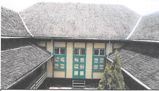
Foto 14. Bentuk atap limasan Keraton Sambaliung ( Dok. BPCB Kaltim, 2019 )
