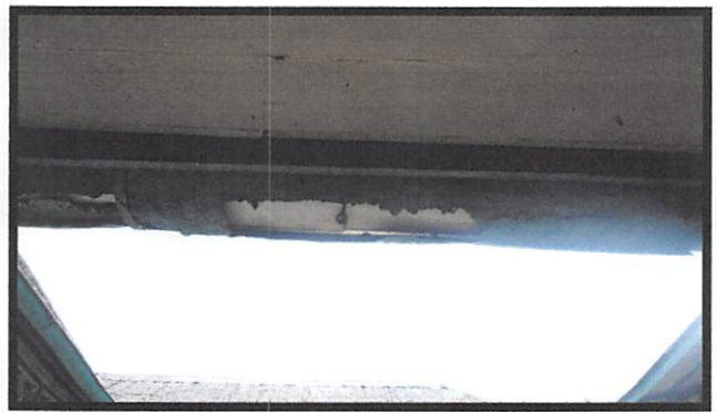
Salah satu kerusakan pada CB di Keraton Sambaliung yaitu pelapukan pada dinding dan korosi talang air
