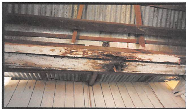
Salah satu kerusakan pada CB di Masjid Kuno Sultan Gunung Tabur yaitu pelapukan dan jamur pada rangka atap dan dinding
