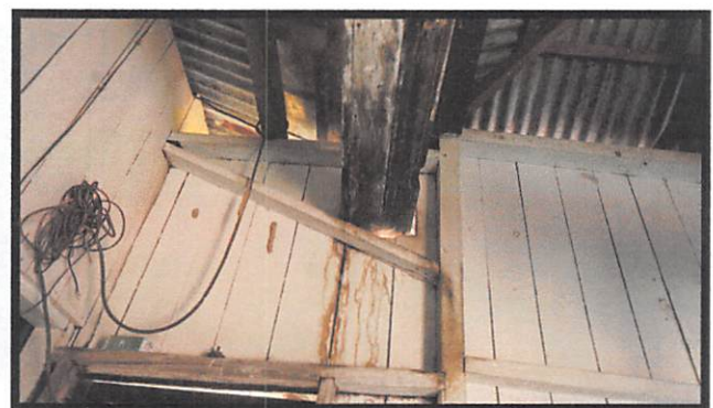
Salah satu kerusakan pada CB di Masjid Kuno Sultan Gunung Tabur yaitu pelapukan dan jamur pada rangka atap dan dinding
