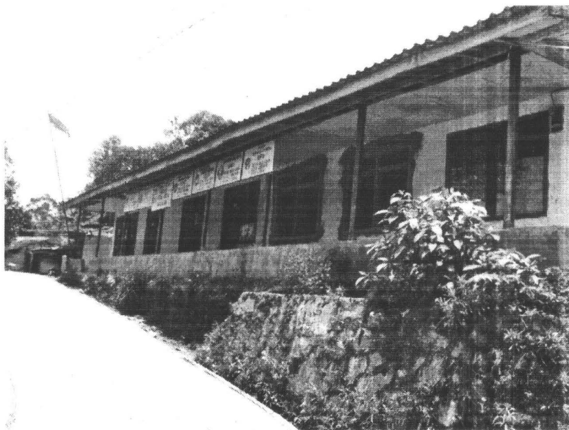
Kantor Desa Neglasari Kecamatan Cibeber Kabupaten Lebak Banten
