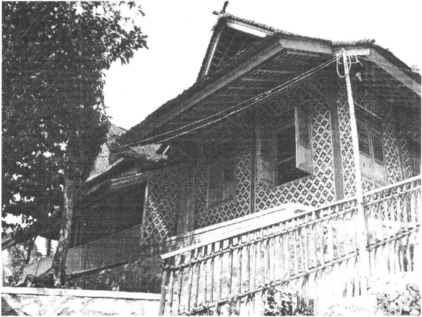
Bagian Belakang Bale Riung dan Rompok Olot Tampak dari Bawah
