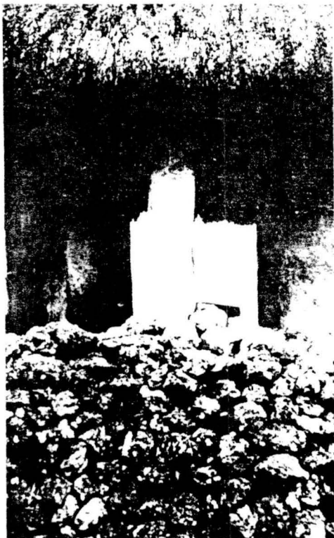
Gbr.3. Tiang-tiang batu rumah marapu Lai Tarung. Pangkal-pangkal tiang ditanamkan dalam tanah tanpa fondasi hanya "dilurung" dengan tumpukkan bebatuan.
