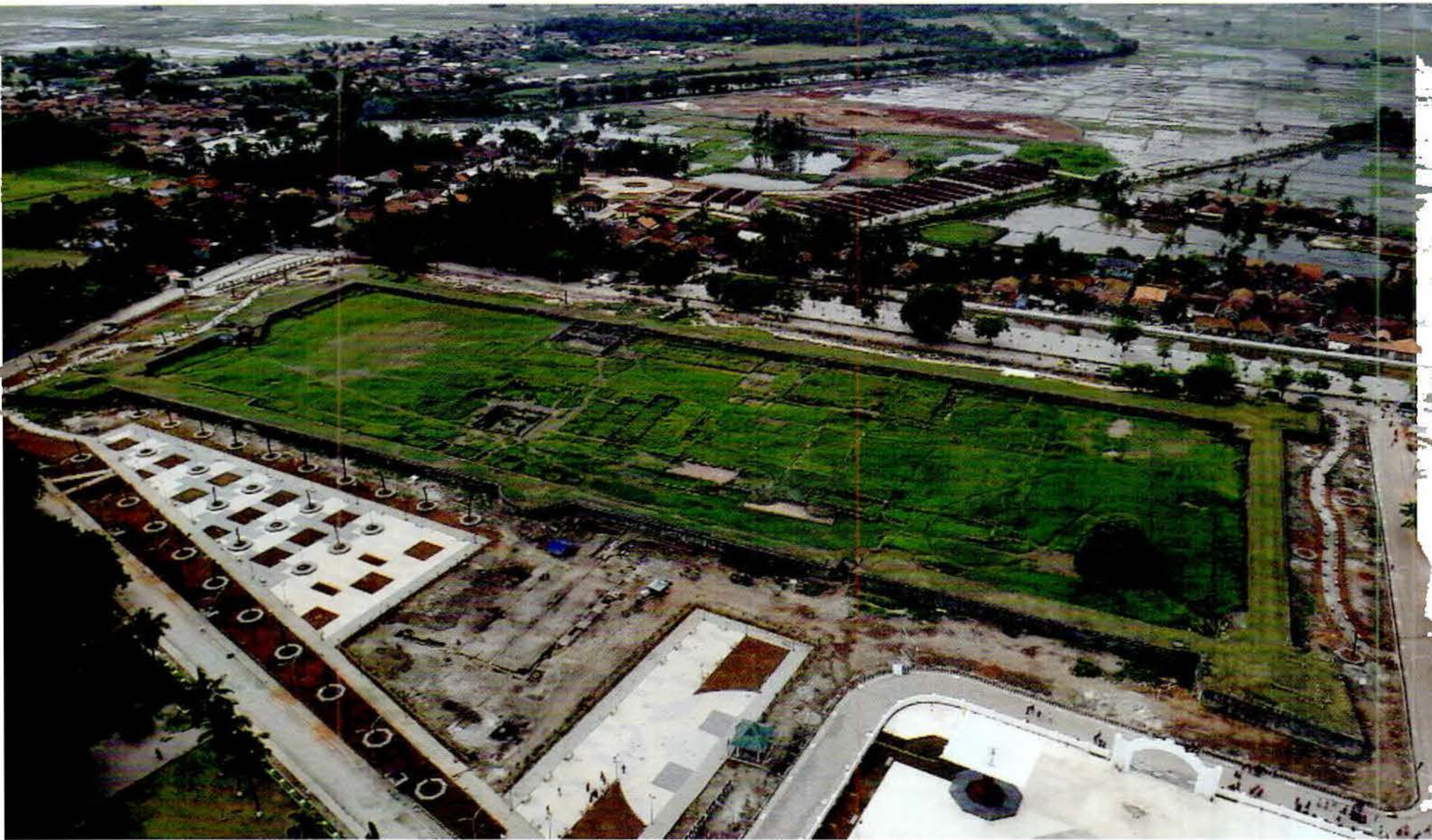
Reruntuhan Keraton Surosowan Banten, tampak atas. Sumber BPCB Banten
