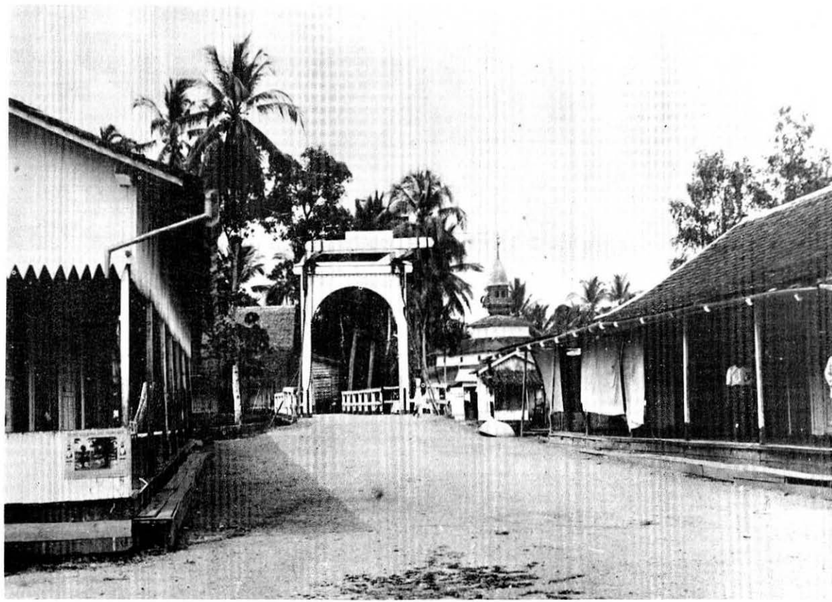
Jembatan Ringkap yang lebih kecil terdapat di Pasar Lama di atas sungai Kuin yang bermuara di sungai Martapura. Semua jembatan Ringkap ini menurut type jembatan Belanda.
