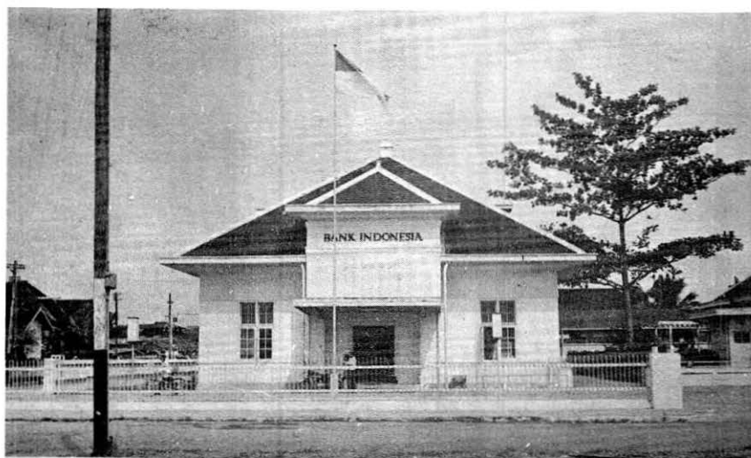
Bekas gedung Javasche Bank zaman Hindia Belanda ini sekarang menjadi gedung Bank Indonesia. Bentuknya tidak ada mengalami perubahan apa-apa.
