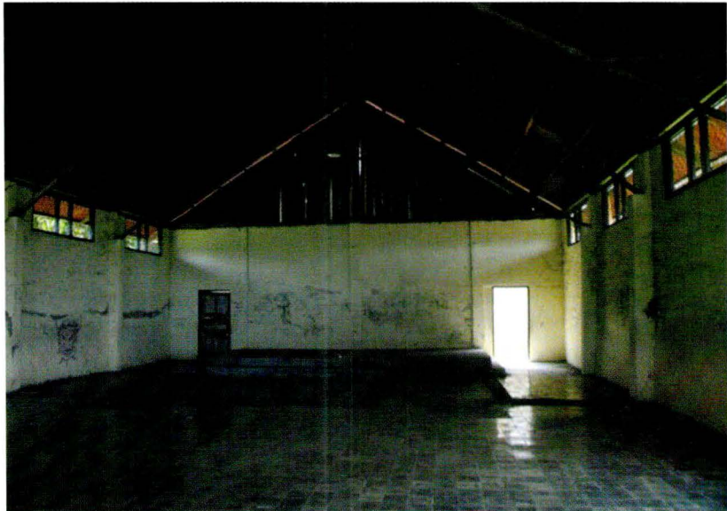
Kondisi gedung Imakulata saat ini (sebelum direnovasi). Gedung ini dahulu digunakan Bung Karno untuk latihan tonil (teater) bersama masyarakat Ende
