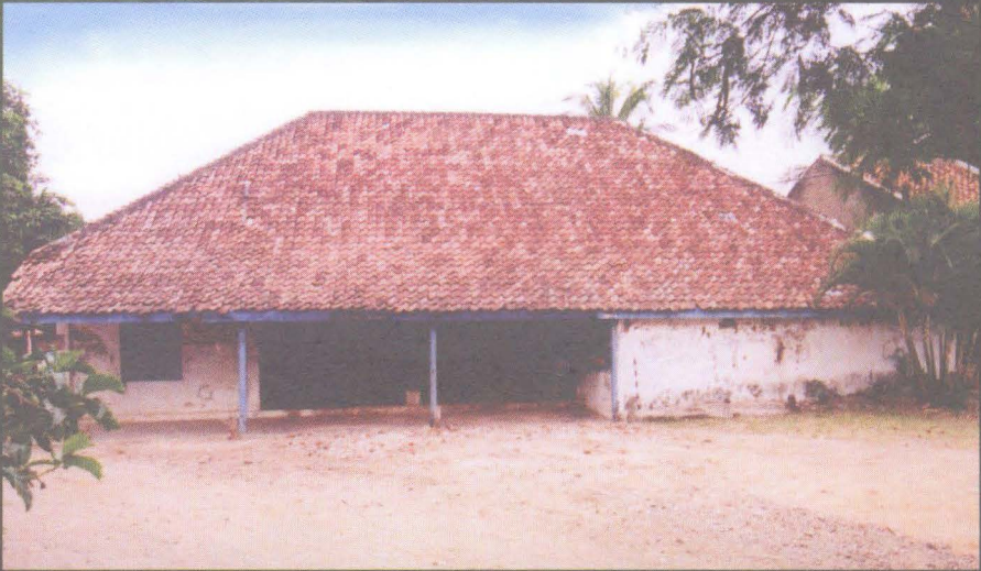
Bangunan tempat penyimpanan garam
