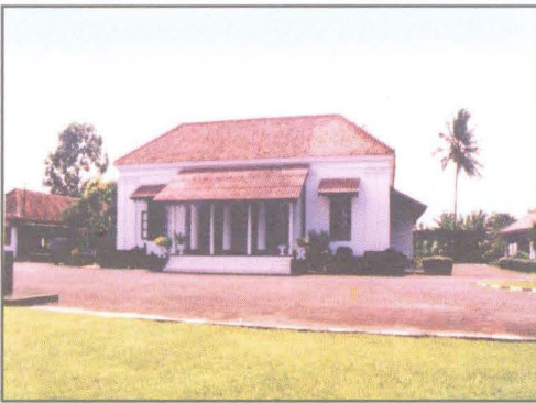
Bangunan KODIM 0601 Pandeglang
