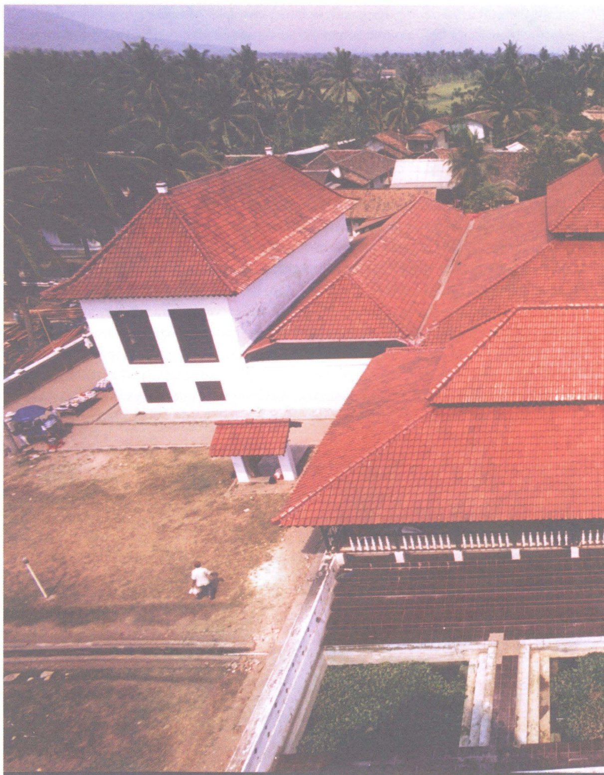
Tampak atas Kompleks Mesjid Agung Banten
