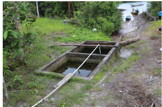
Kondisi Sumur Jepang Muara Simpak.
