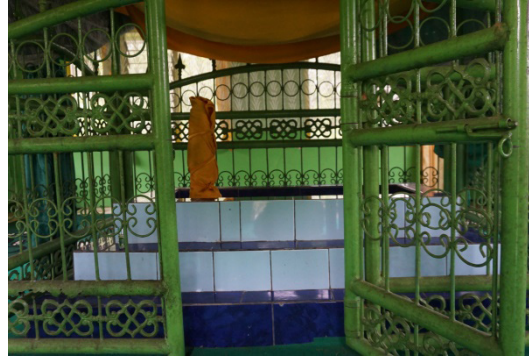
Makam Habaib Muhammad Sholeh Al Idrus yang telah mengalami renovasi. (Sumber: BPCB Kalimantan Timur 2020)
