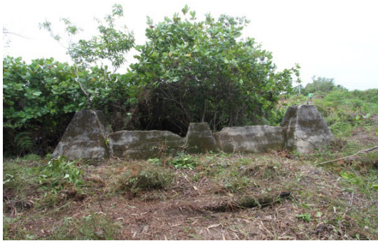
Salah satu tinggalan struktur pondasi Menara Sumur Minyak.
