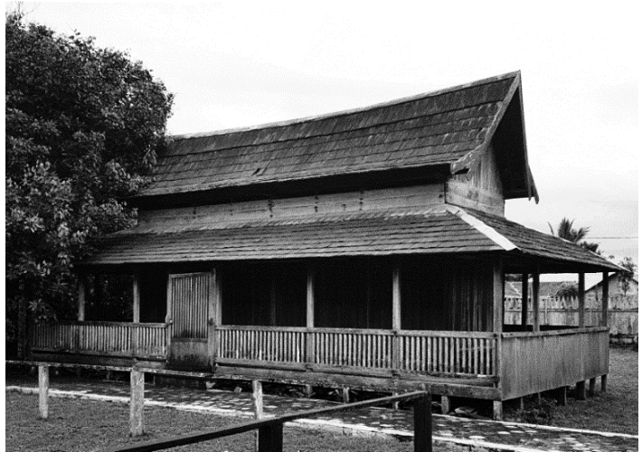
Foto 1: Pagongan setelah mengalami pemugaran
