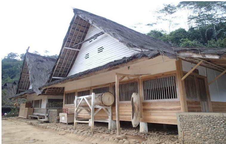
Gambar 2. Bangunan di Kampung Naga (dari depan-samping). (Sumber: blog.negerisendiri.com ).
