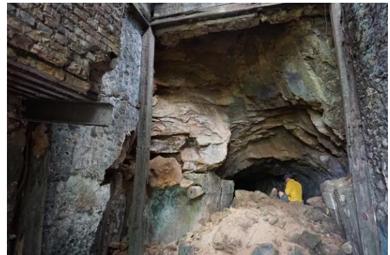
Foto 3. 52 Pintu masuk yang tertutup longsoran tanah dari atas (Dok. BPCB Kalimantan Timur, 2019)
