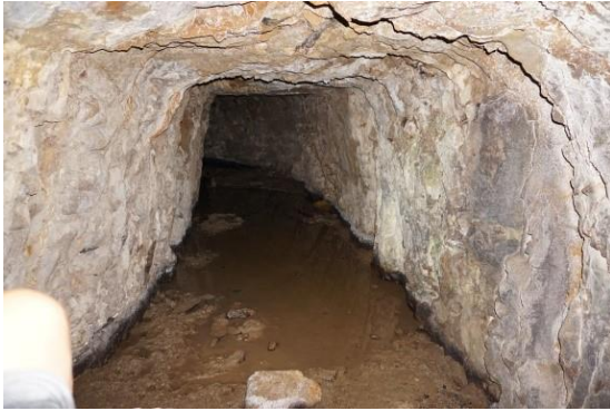
Foto 3. 53 Bagian dalam terowongan tambang batu bara yang tergenang air (Dok. BPCB Kalimantan Timur, 2019)
