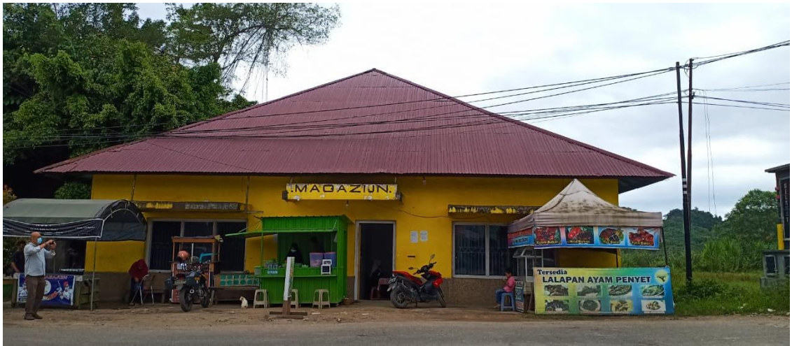
Foto 3. 48 Tampak depan Kantor Magazijn Loa Kulu (Dok. BPCB Kalimantan Timur, 2020)
