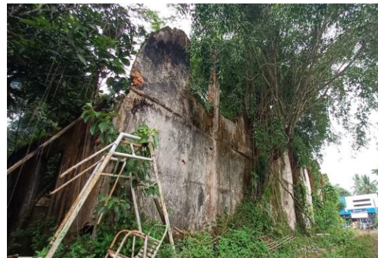
Foto 3. 45 Tampak belakang Gedung Atap Lengkung (Dok. BPCB Kalimantan Timur, 2020)
