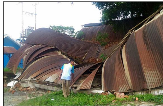
Foto 3. 43 Robohnya atap bagian depan gudang atap lengkung (Dok.
