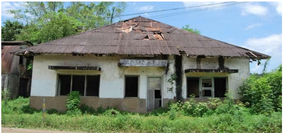
Foto 3. 49 Ex Tampak depan Kantor Magazijn Loa Kulu (Dok. BPCB Kalimantan Timur, 2018)
