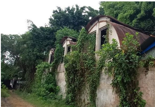
Foto 3. 44 Tampak Samping Kanan Gedung Atap Lengkung (Dok. BPCB Kalimantan Timur, 2020)
