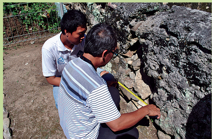
Identifikasi dan penghitungan kerusakan struktur dan arsitektur pada Makam Raja Blongkod dalam rangka pemugaran
