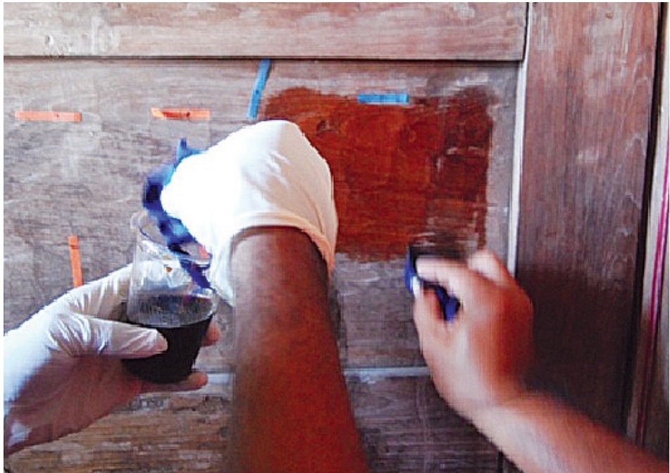
Foto 4.(kiri) : Bahan konservasi tradisional (Campuran tembakau, cengkeh, kulit batang pisang kering). Foto 5 (kanan) : Pengolesan bahan konservasi tradisional (Campuran tembakau, cengkeh, kulit batang pisang kering) pada bagian dinding Bangunan Cagar Budaya berbahan kayu. Diambil ketika kegiatan Diklat Konservasi Tingkat Menengah di Balai Pelestarian Konservasi Borobudur, Magelang.
