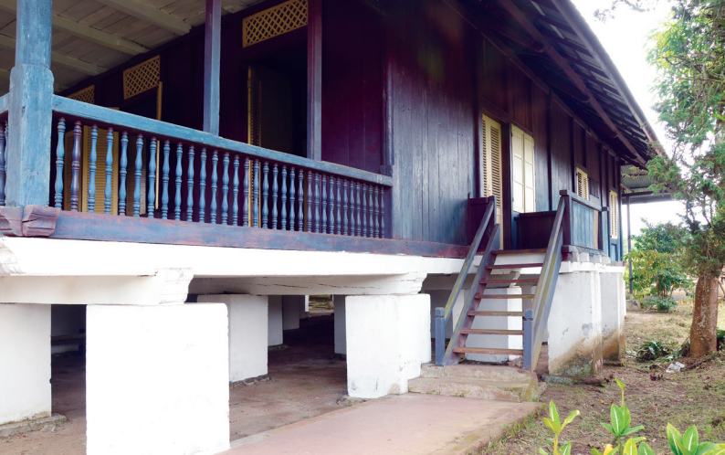
Foto 3. Dinding dan tiang penyangga rumah di bagian samping kiri bangunan Loji Tondano (Dok. BPCB Gorontalo).
