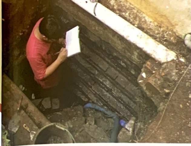
Kegiatan Pengalian pemeriksaan bentuk pondasi yang pernah dilakukan BPCB Serang bekerjasama dengan Pusat Dokumentasi Arsitektur Indonesia.
