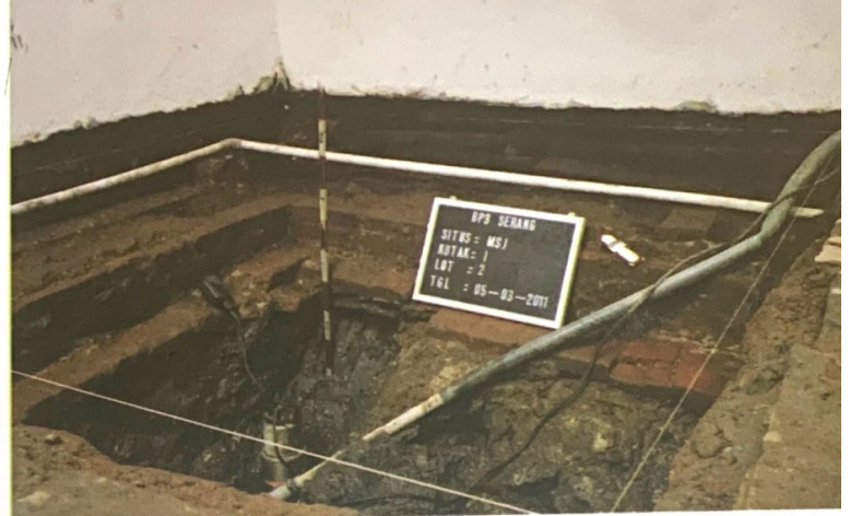
Kegiatan Pengalian pemeriksaan bentuk pondasi yang pernah dilakukan BPCB Serang bekerjasama dengan Pusat Dokumentasi Arsitektur Indonesia.
