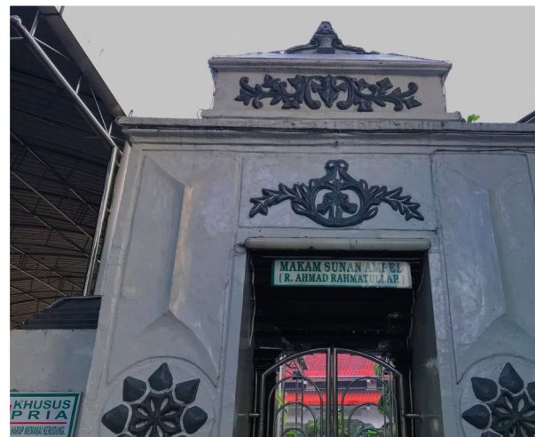
Gapuro Paneksen (Dokumen Pribadi, 2022)
