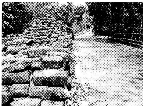
Sisa dinding benteng bagian dalam (ceपुरi) yang dibangun dengan bahan batu putih (Foto: Sugeng Riyanto)
