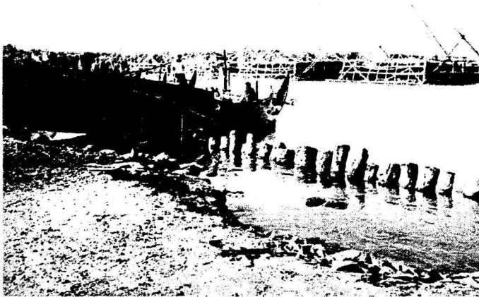
Gb II.2. Tanah Yang Terkikis Air Untuk Pengendaliannya Dipasang Patok Kayu
