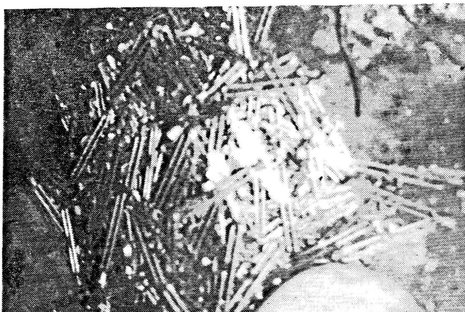
15. Potongan-potongan besi beton untuk dibuat band sesuai ukuran yang dibutuhkan.
