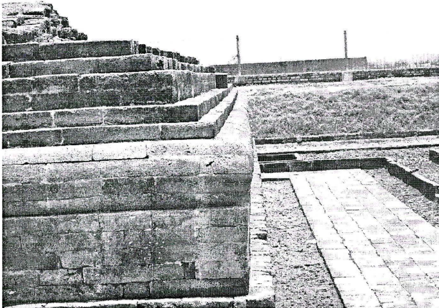
Lapisan perekat sangat tipis dari bahan stucco yang terlihat pada kaki candi Jiwa (dok. Nanang S, 2007)
