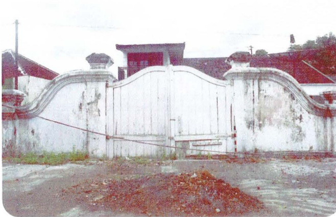
Pintu gerbang Alun-alun pada sisi selatan
