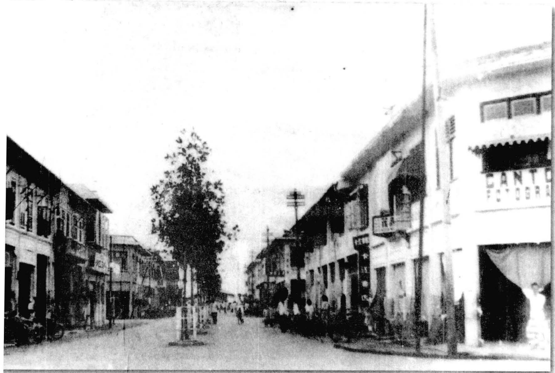
Gambar 3.6 Jalan Pasar Tengah tahun 1950an (Sumber: Koleksi Marius A.P)
