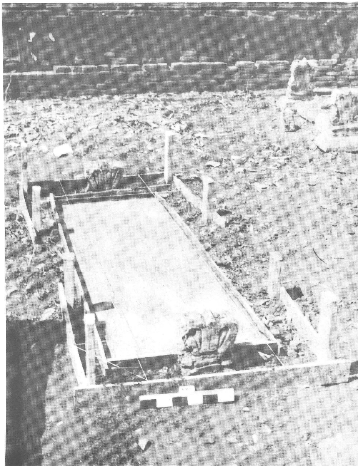
Foto No. 5/MM. Pembetonan untuk fondasi Makam (Kompleks Makam/Mesjid Mantingan, Jepara Jawa Tengah).
