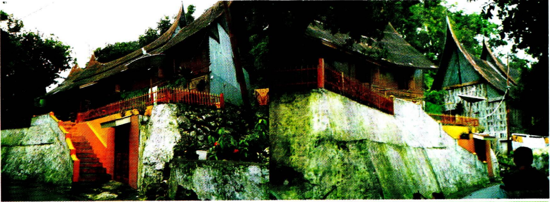
Gambar 15. Rumah Gadang Sumpur yang telah mengalami perobakan
