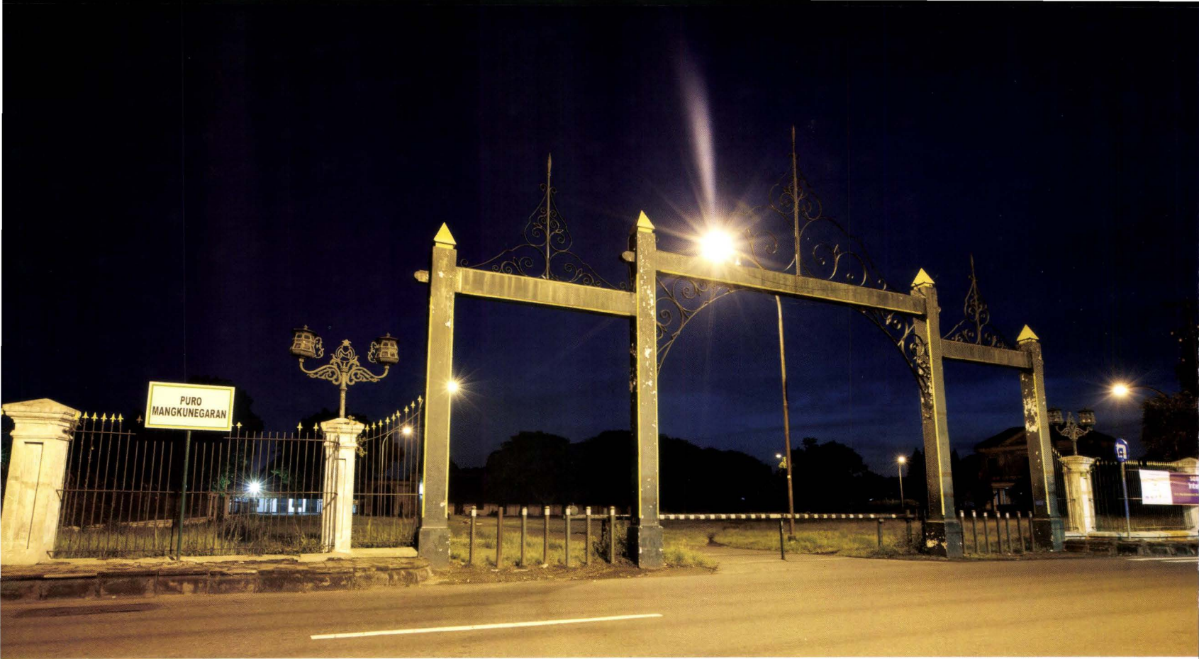
Gapura utama puro yang tersisa hanya tiang-tiang besinya. Iron poles - the only remainings of the main gateway of the Puro
