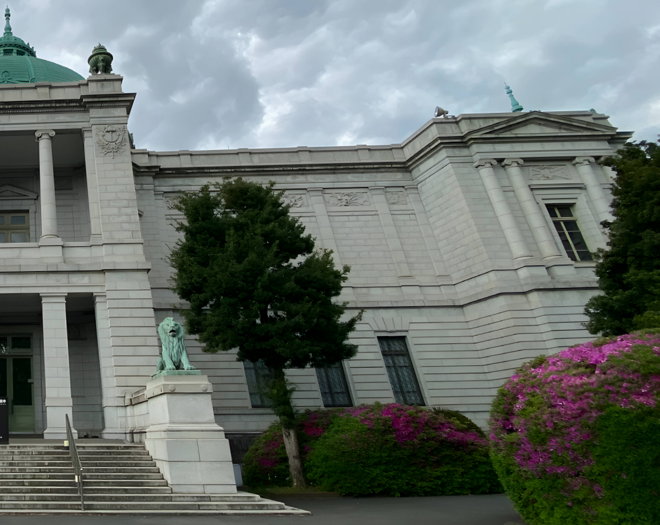
Tampak Depan Hyokeikan Building TNM. Foto Zulfa Nurdina
