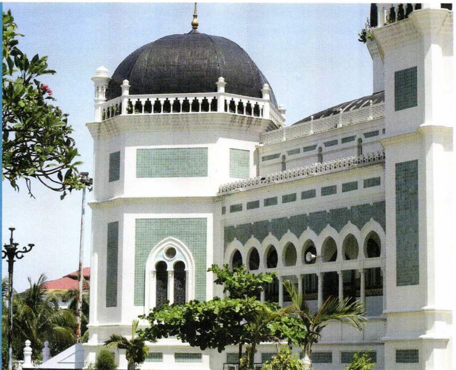
Bangunan Mesjid tampak sebelah kiri
