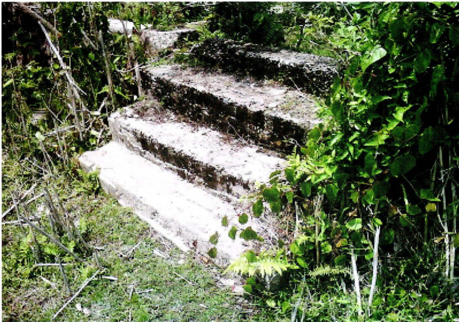
Keterangan: Tangga bekas bangunan mesin pembangkit
