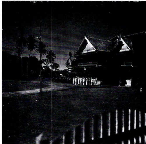
Keterangan: Tiang listrik dekat Istana Bulungan Sumber: www.bulungan.go.id
