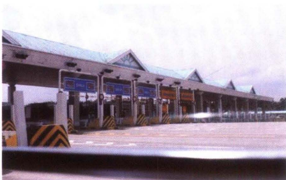
Foto 1. Pintu Jalan Tol Menuju Bandara Internasional Kuala Lumpur (dokumentasi tim 2011)
