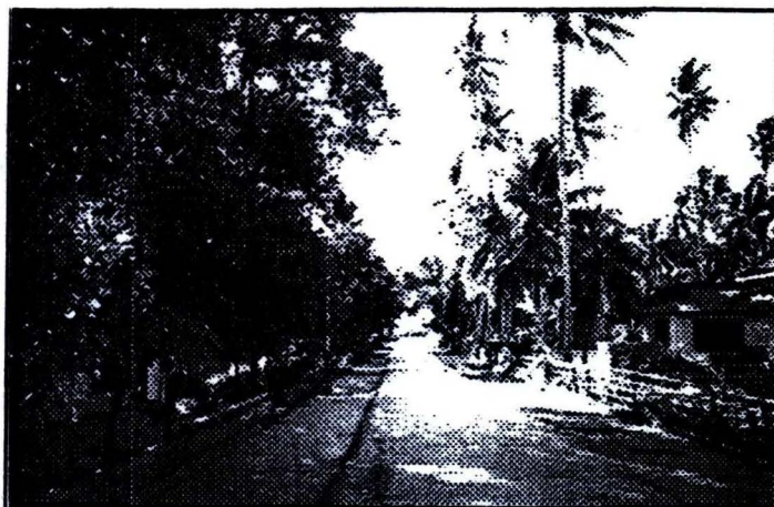
Gambar 3. Jalan di Kampung Marore yang telah dibeton
