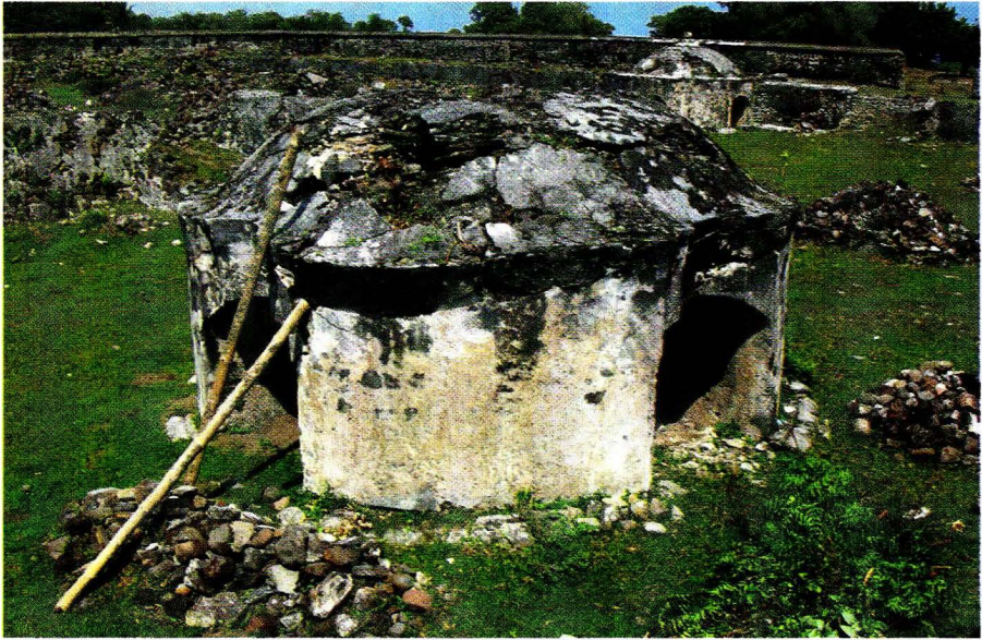
Foto 18. Kerusakan Struktural Benteng Indrapatra Aceh Besar NAD
