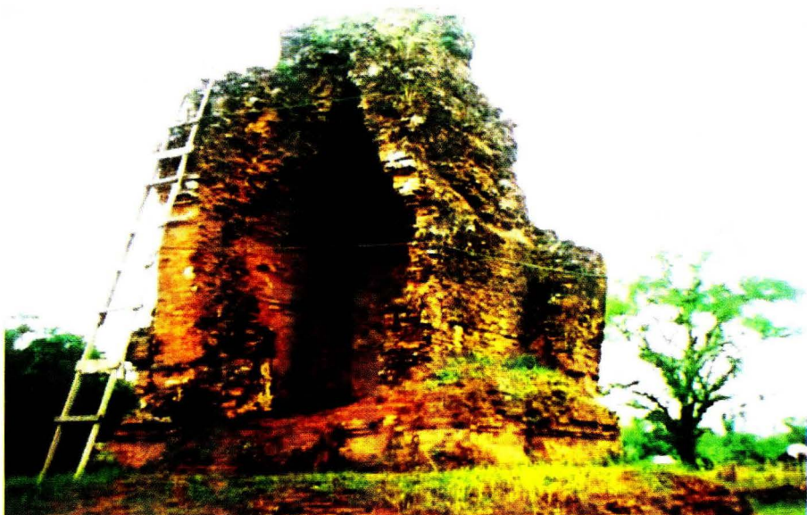
Foto 15. Kerusakan Arsitektural dan Struktural Candi Bahal II Padang Lawas Sumatera Utara
