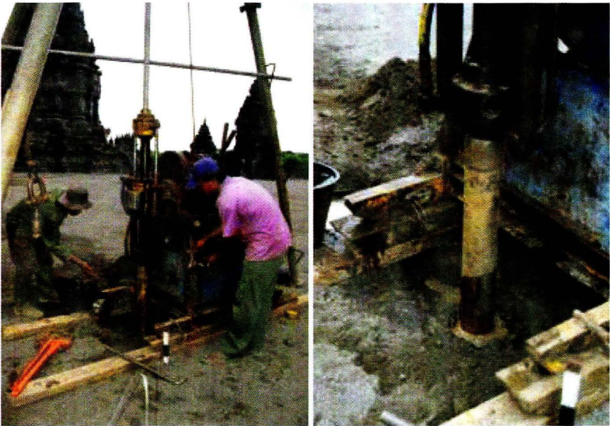
Gambar 4.1. Uji bor mesin (Coring, SPT dan Lugeon test)
