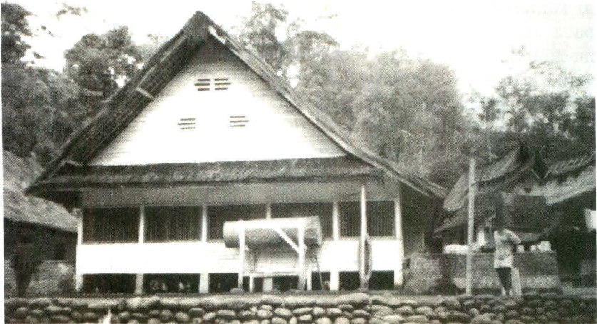
Gambar 6 Sebuah Bangunan Mesjid.
