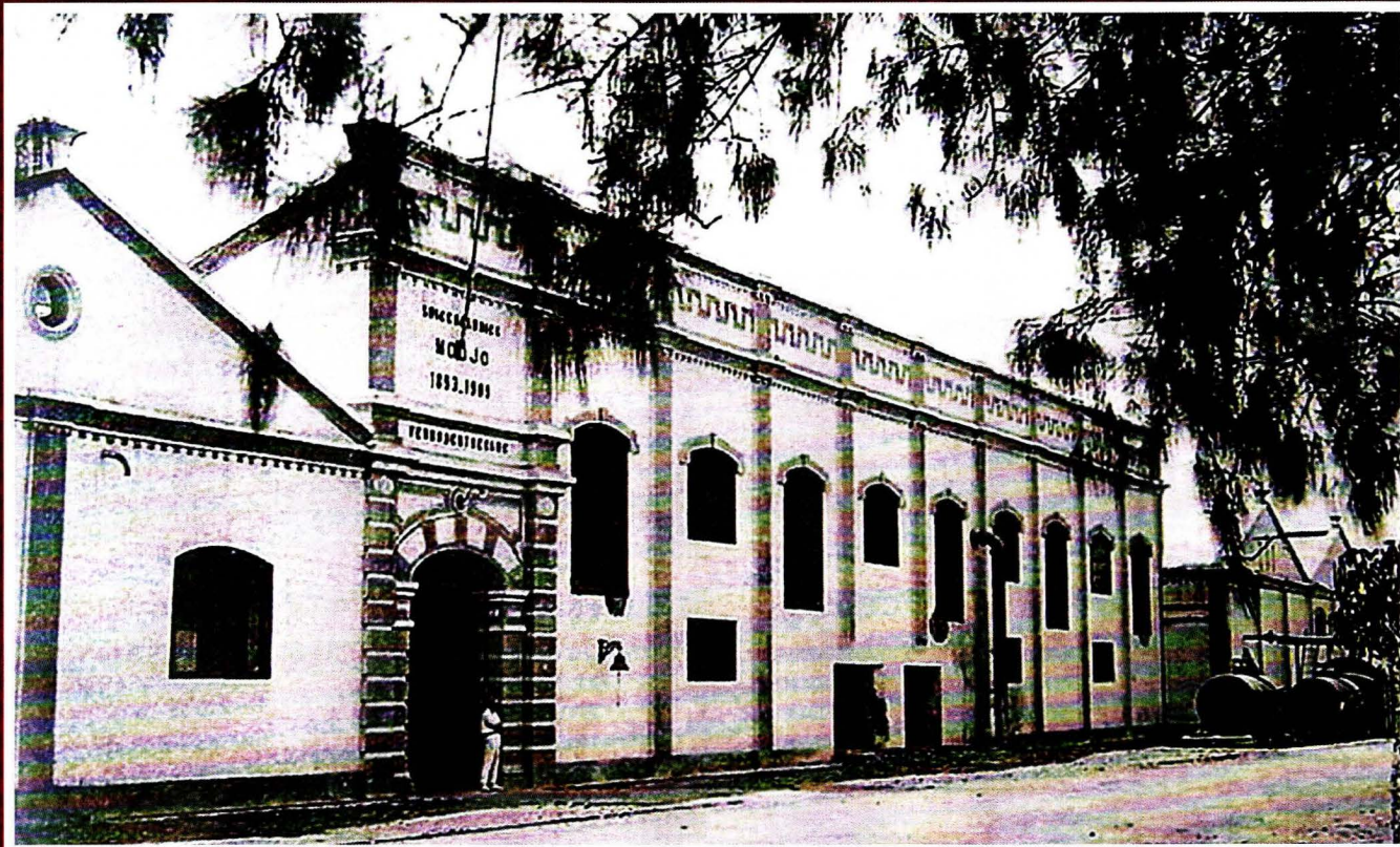
■ PG Modjo Sragen - bangunan utama ( 1940-an)
