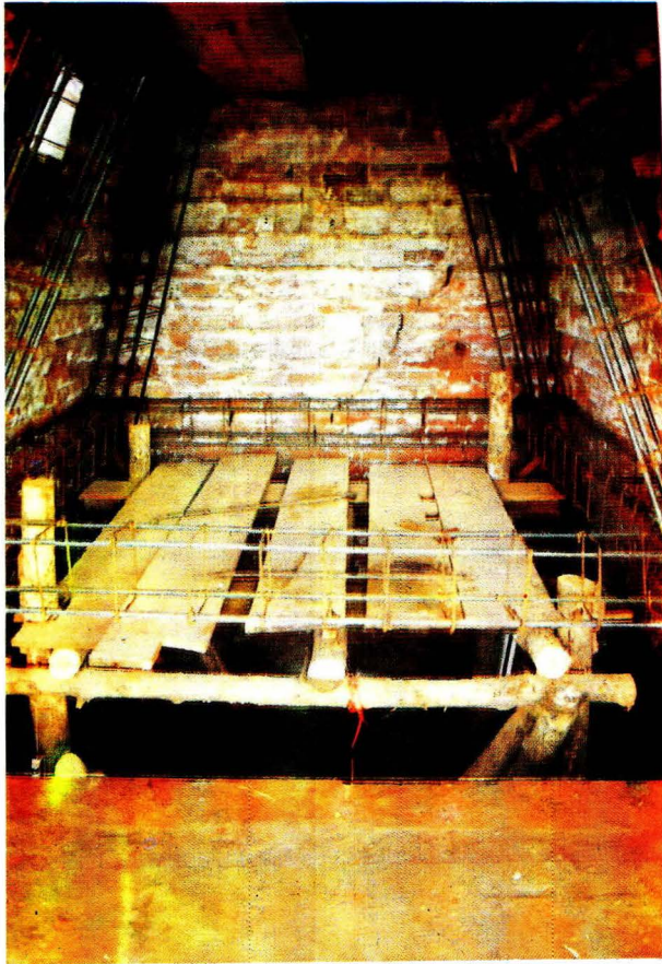
Foto 7: Konstruksi perkuatan pada bilik candi
