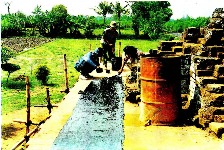
Foto 9: Pengolesan lapisan kedap air ( araldite ) pada permukaan bata bagian dalam
