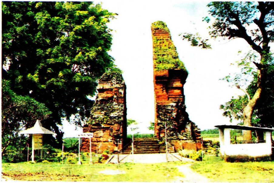
Foto 1: Kondisi gapura sebelum dipugar
