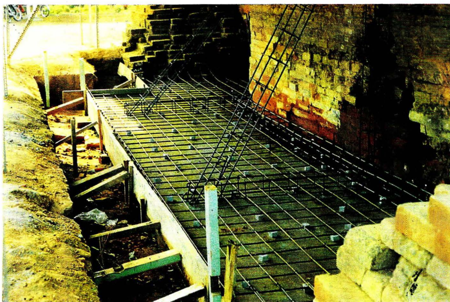
Foto 6: Konstruksi perkuatan pada kaki candi
