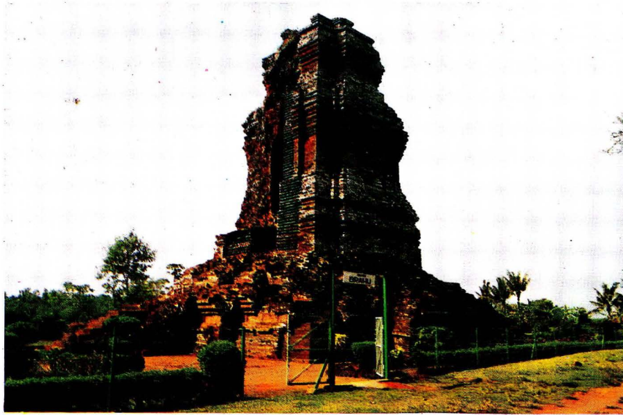
Foto 1: Kondisi candi sebelum dipugar (tampak Barat-daya)
