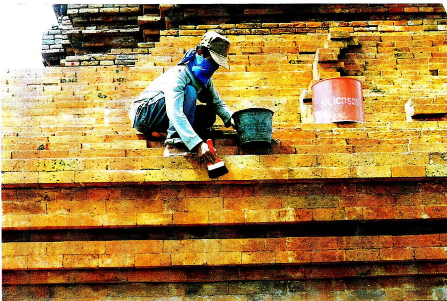
Foto 10: Pengolesan lapisan kedap air ( silico-so1 ) pada permukaan bata kulit
