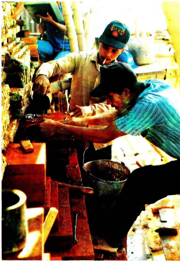
Foto 7: Kegiatan pemasangan kembali bata bagian tubuh gapura
