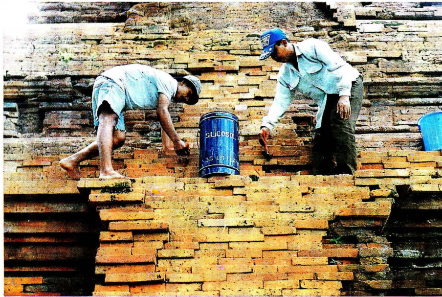
Foto 9: Pengolesan lapisan kedap air ( silicoseal ) pada permukaan bata
