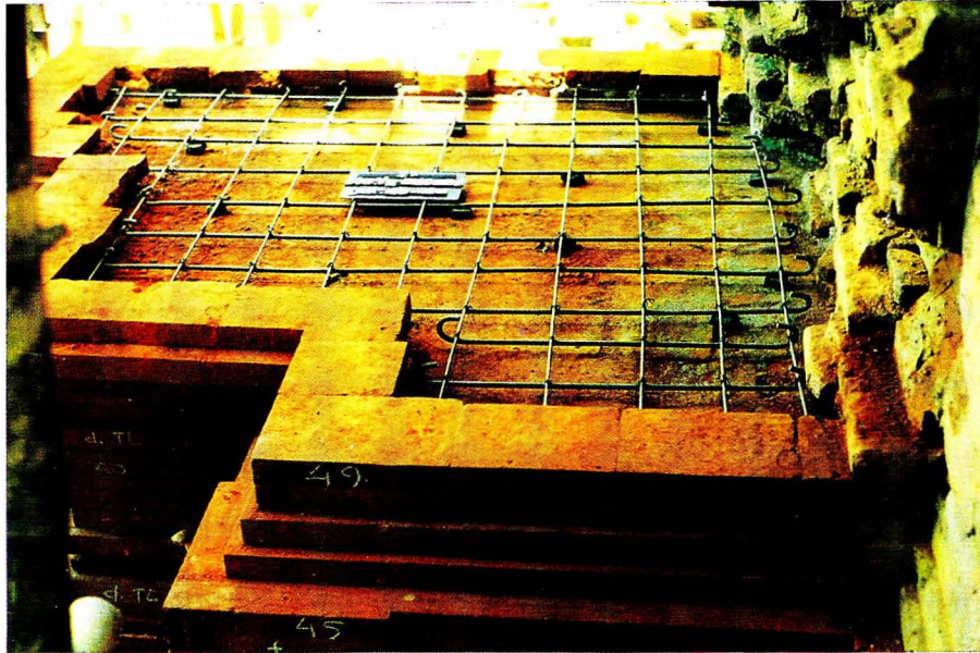
Foto 5: Konstruksi perkuatan beton
