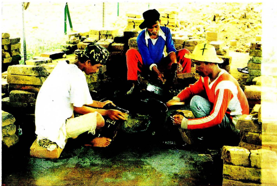
Foto 5: Kegiatan pembersihan bata candi hasil pembongkaran
