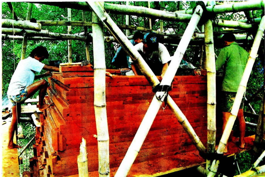
Foto 8: Kegiatan pemasangan kembali bata bagian atap gapura
