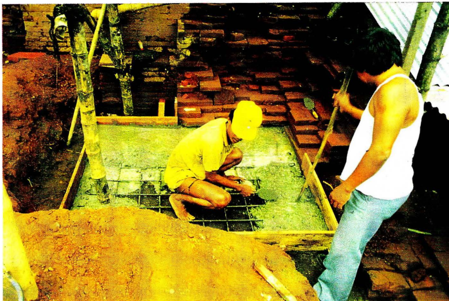
Foto 6: Kegiatan pengecoran beton pada bagian kaki
