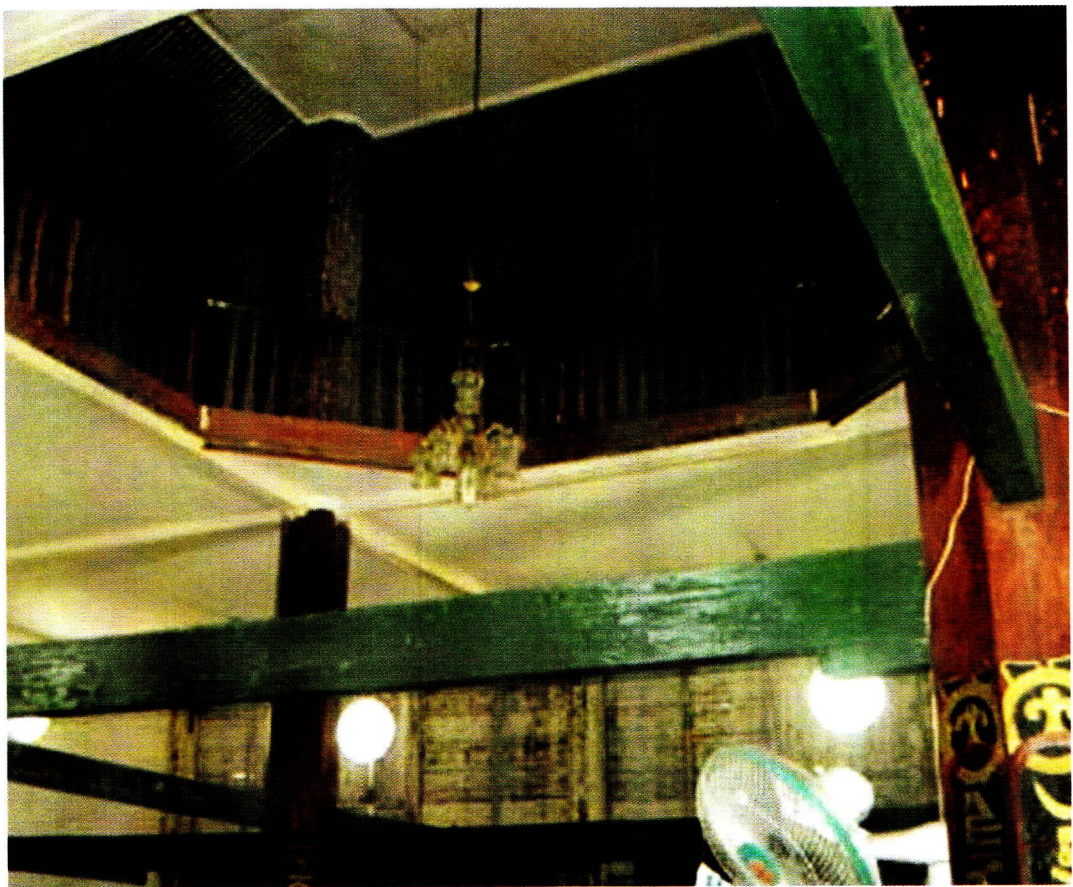
Detail bagian atap masjid Nurul Huda Pulo Kameng
