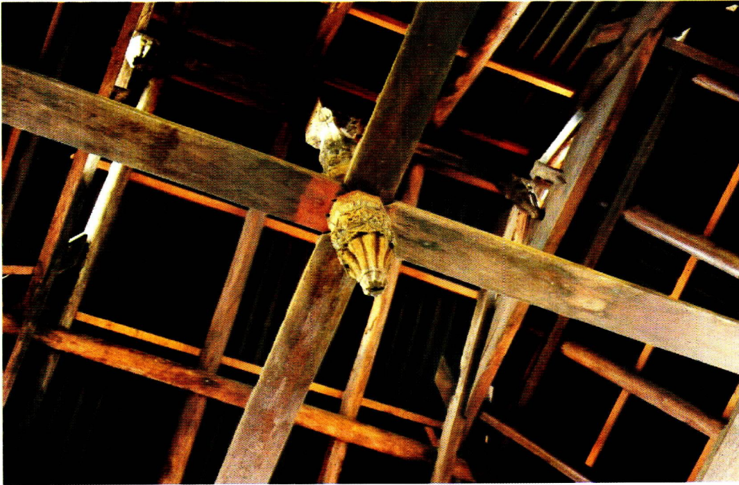
Detail balok tengah sebagai penguat konstruksi bangunan masjid Tuha Ulee Kareng
