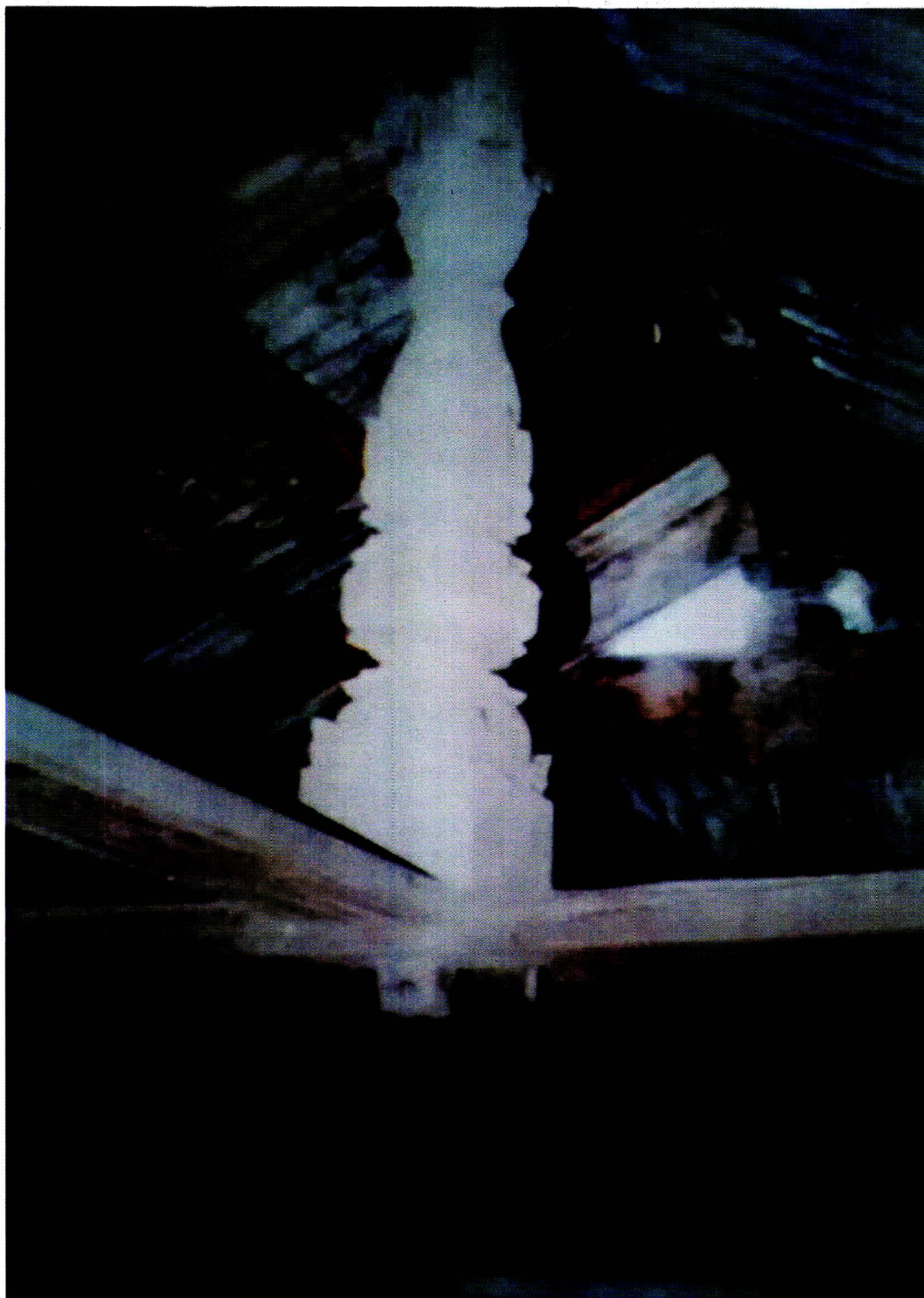
Balok tengah yang berfungsi sebagai penguat konstruksi atap paling puncak.
