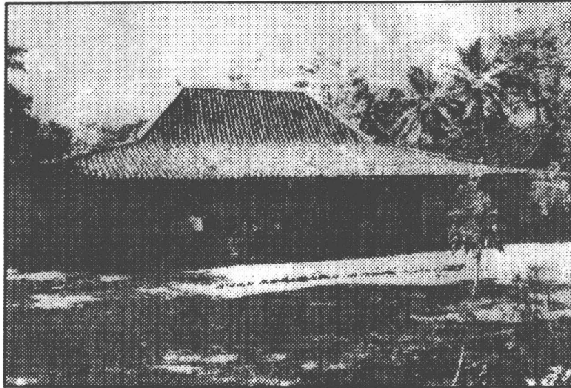
Bangunan rumah tempat tinggal yang berbentuk Limasan emper keliling dengan rumah gandok bentuk kampung. (Bantul)
