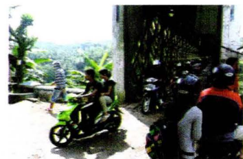
Selain sebagai Lintasan Kereta Api (Atas) Jembatan juga sebagai Lintasan Kendaraan Beroda Dua (Bawah)
