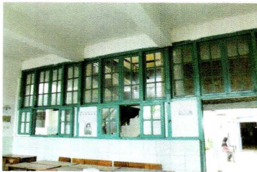
Bentuk jajaran jendela dan pintu pada facade bangunan ketiga. Tampak bagian atasnya telah dirubah menjadi bangunan berkontruksi dua lantai
