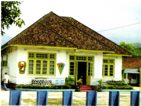
Bangunan Markas CPM Sumedang dilihat dari muka
