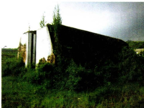
Bagian muka bunker tampak bagian pintunya
