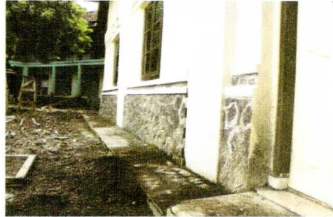
Kondisi dinding masonry dan sisa lantai asli
