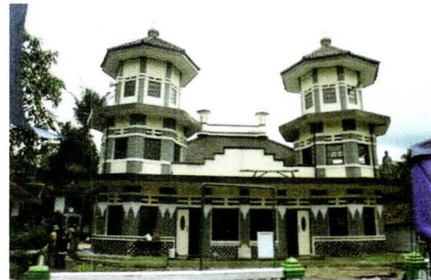
Kondisi bangunan masjid setelah renovasi tahun 2010
