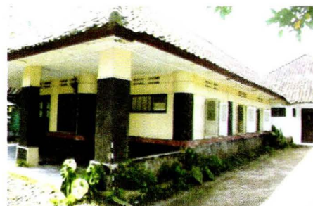
Pilar Semu dan Hiasan Masonry pada dinding
