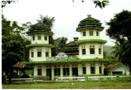
Kondisi bangunan Masjid sebelum renovasi tahun 2010
