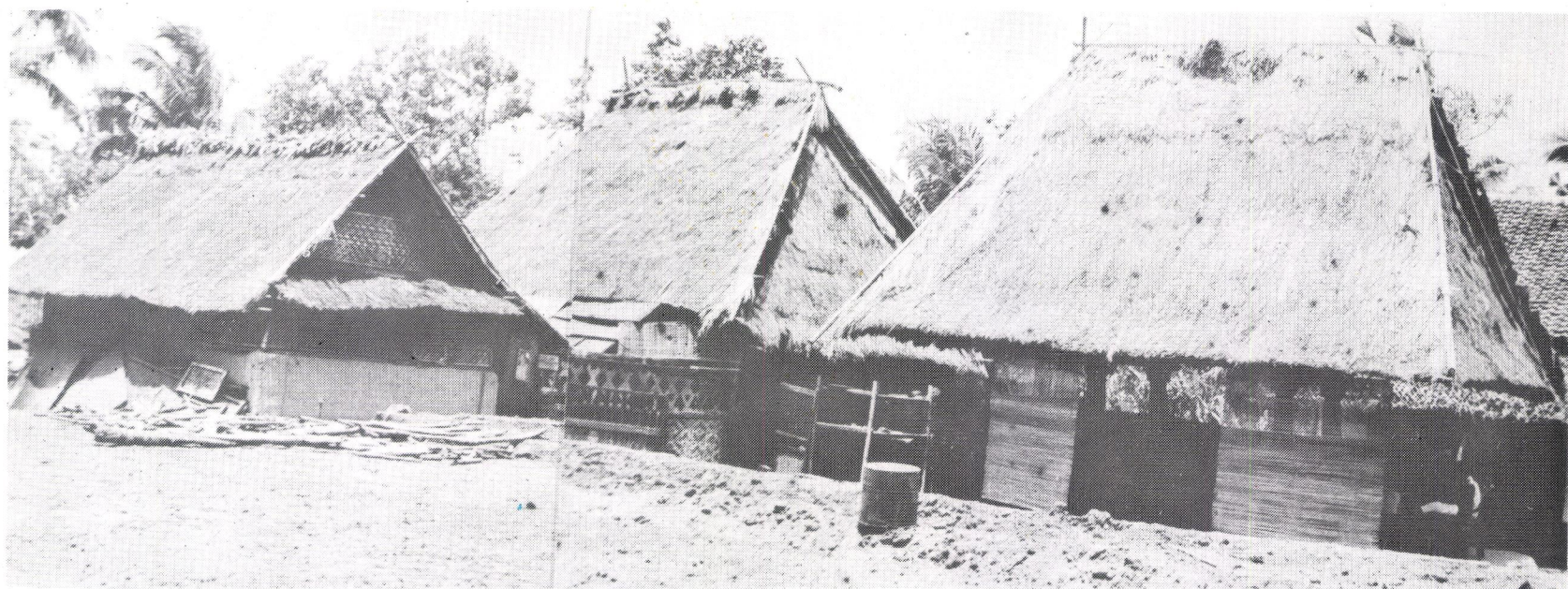
Rumah Adat Lombok dari desa Denggen, Selong, Lombok. Bangunan menggunakan kayu, dengan atap daun ilalang.
