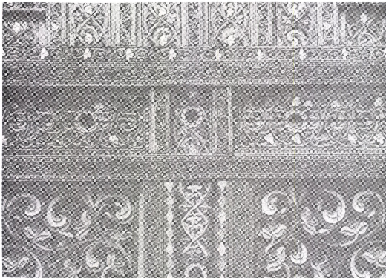
Salah satu detail dari hiasan dinding Balai Adat Kab. Tanah Datar. Perhatikan bulatan-bulatan tempat cermin yang sudah terlepas dan hilang.
