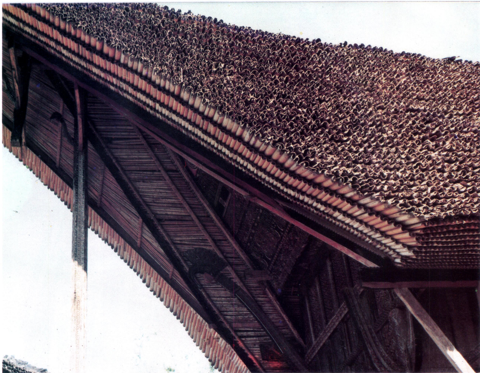
Bubungan pada Tongkonan di Ketekesu. Atap dibuat dari bambu yang dibelah dua dan disusun telungkup dan telentang untuk menahan air hujan.
