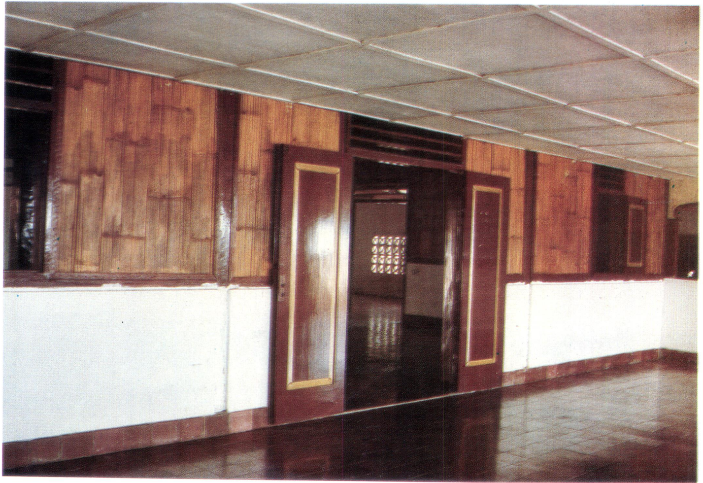
Dinding masjid Allalam Cilincing, bagian depan atau bagian timur.
