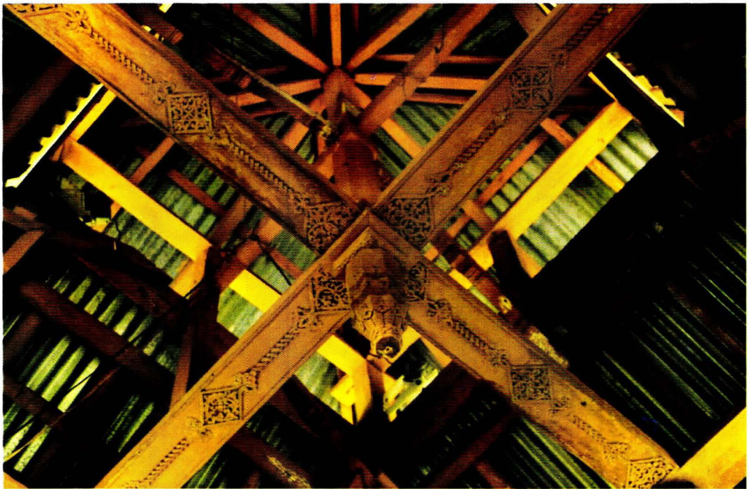
Detail ornamen konstruksi penyangga atap
