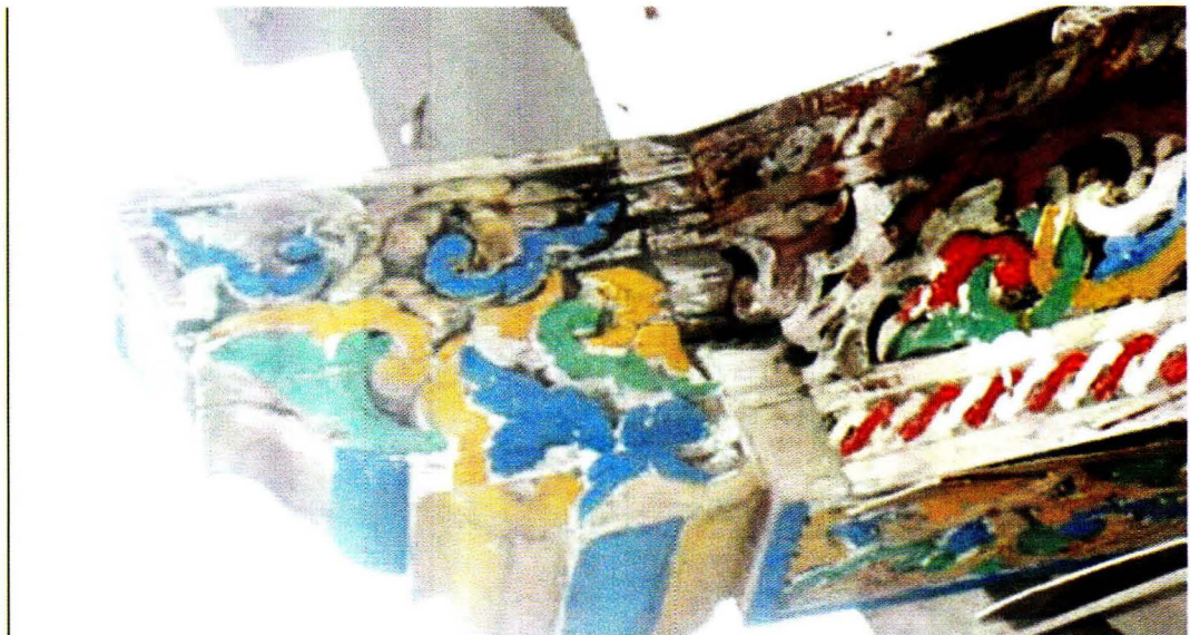
Ornamen yang dijumpai pada bagian ujung balok kayu penyangga atap
